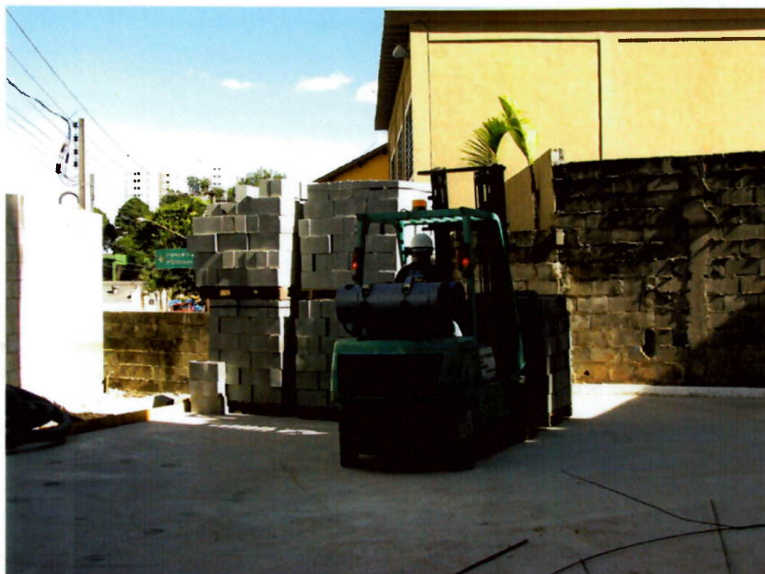
Figura 18 - Blocos transportados em paletes por empilhadeira.
