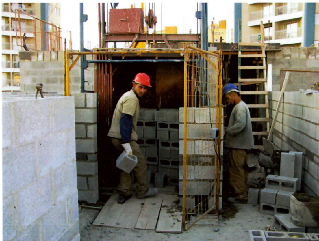
Figura 19- Guincho instalado dentro do poço definitivo de elevador.
