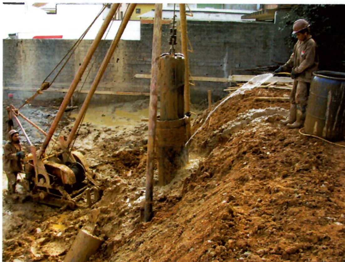
Figura 9 - Execução de estaca Strauss.
