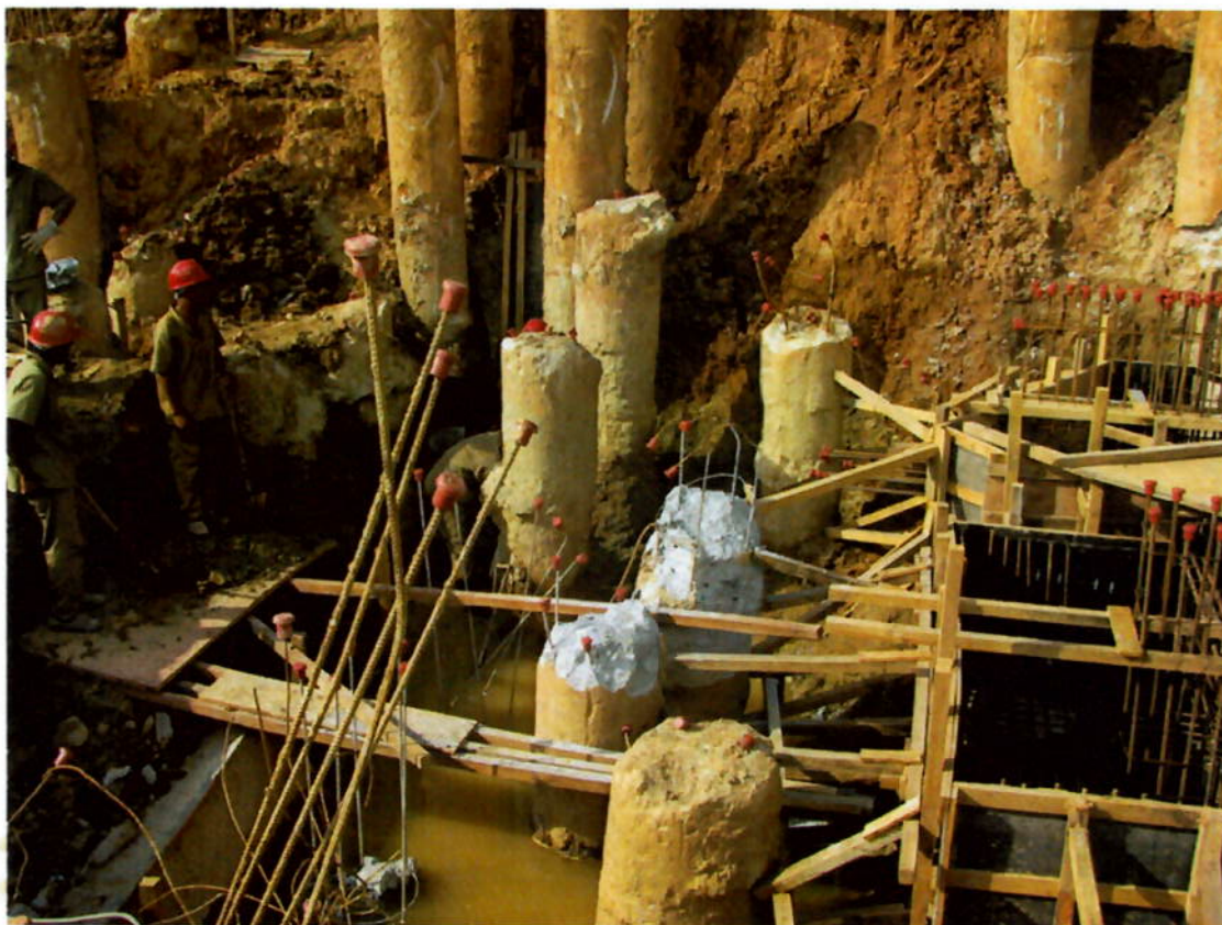
Figura 13 - Estacas com fuste à mostra por causa de desmoronamentos.
