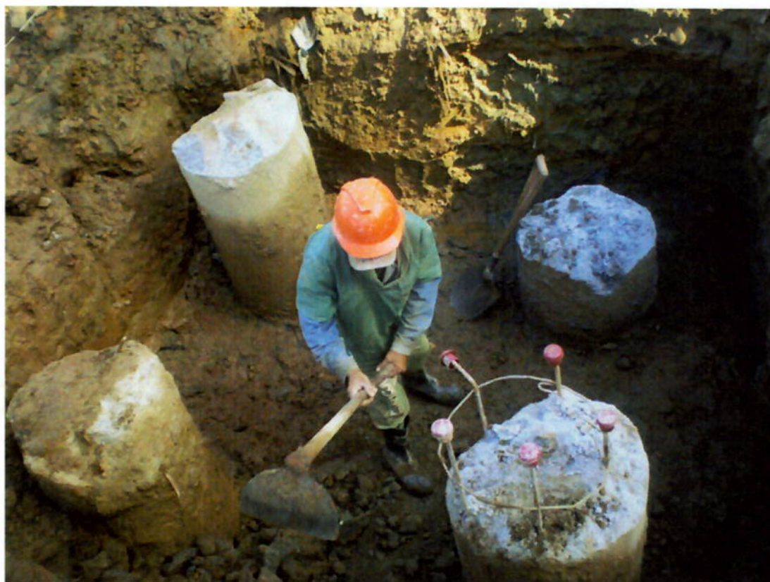
Figura 12 - Escavação manual de bloco.
