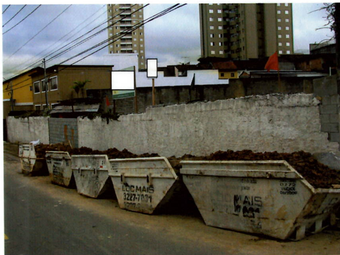
Figura 11 - Caçambas com resíduos das estacas - lama
