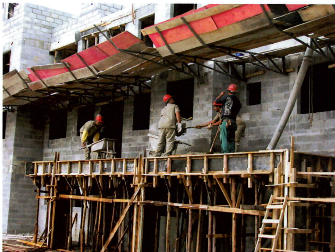
Figura 14 - Execução de peça em concreto armado e alvenaria estrutural.
