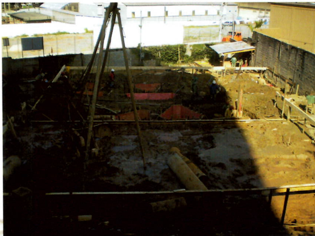
Figura 6 - Gabarito em diferentes níveis e sequência de etapas.
