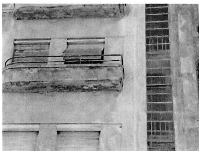
Figura 9 – Perda de Aderência ou Desagregação (foto, MOTA, 2002).
