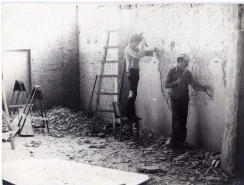
Imagem 9. Retirada do reboco das paredes originais do Galpão de atividades gerais. Fonte Arquivo Lina Bo Bardi e P. M. Bardi. Sem crédito. In OLIVEIRA, Liana P. P. (2007)
