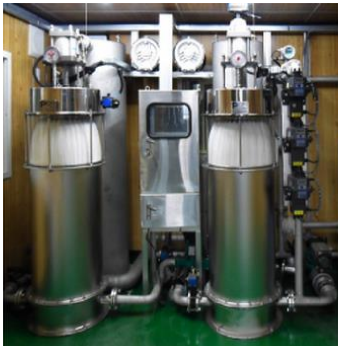
Figura 4 – Unidade de filtro de fibra flexível WTP-225 da empresa SENG. Fonte: SENG 2
