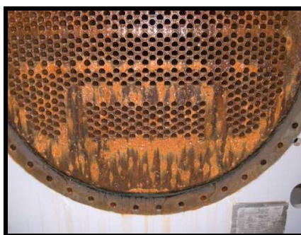
Figura 6 – Material orgânico no espelho de um condensador
