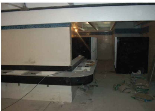
Foto 11 - Adequação de bancadas para garantir a entrada da cadeira de rodas sob as mesmas, facilitando o uso, também para pessoas com mobilidade reduzida.
