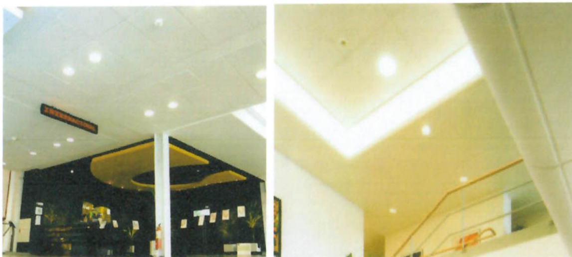
Figura 12 - Forros em lã de vidro – fonte: catálogo - Isover
