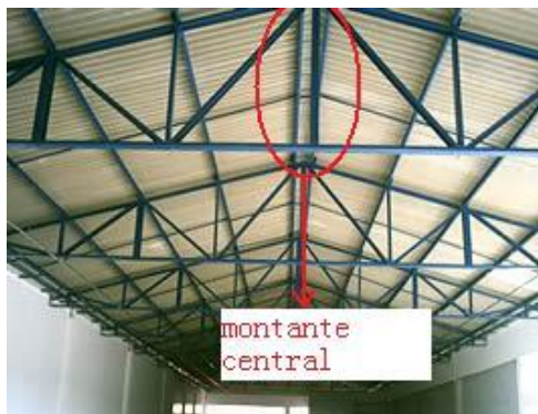
Figura 3.4 – exemplo de telhado de duas águas
