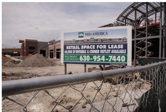
Figura 2.1- Strip Mall em construção com área para locação de 5600 m 2 .
