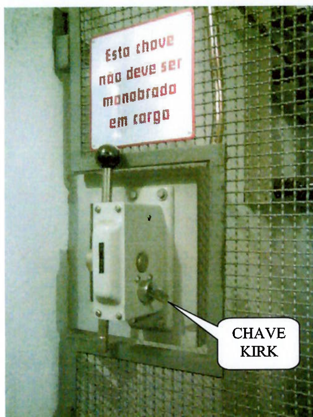
Figura 16 – Manúbrio da chave seccionadora “sem carga”
