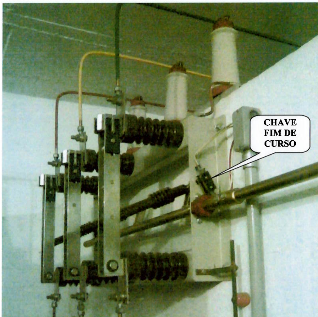
Figura 17 – Chave seccionadora “sem carga” provida de chave fim de curso
