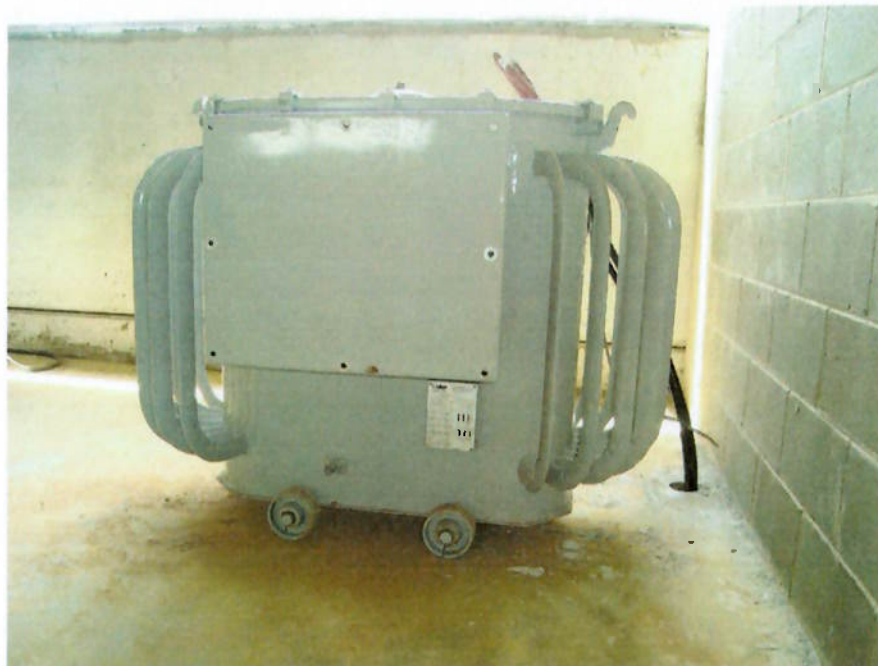
Figura 9 – Transformador - Isolação a óleo mineral – 45 kVA.
