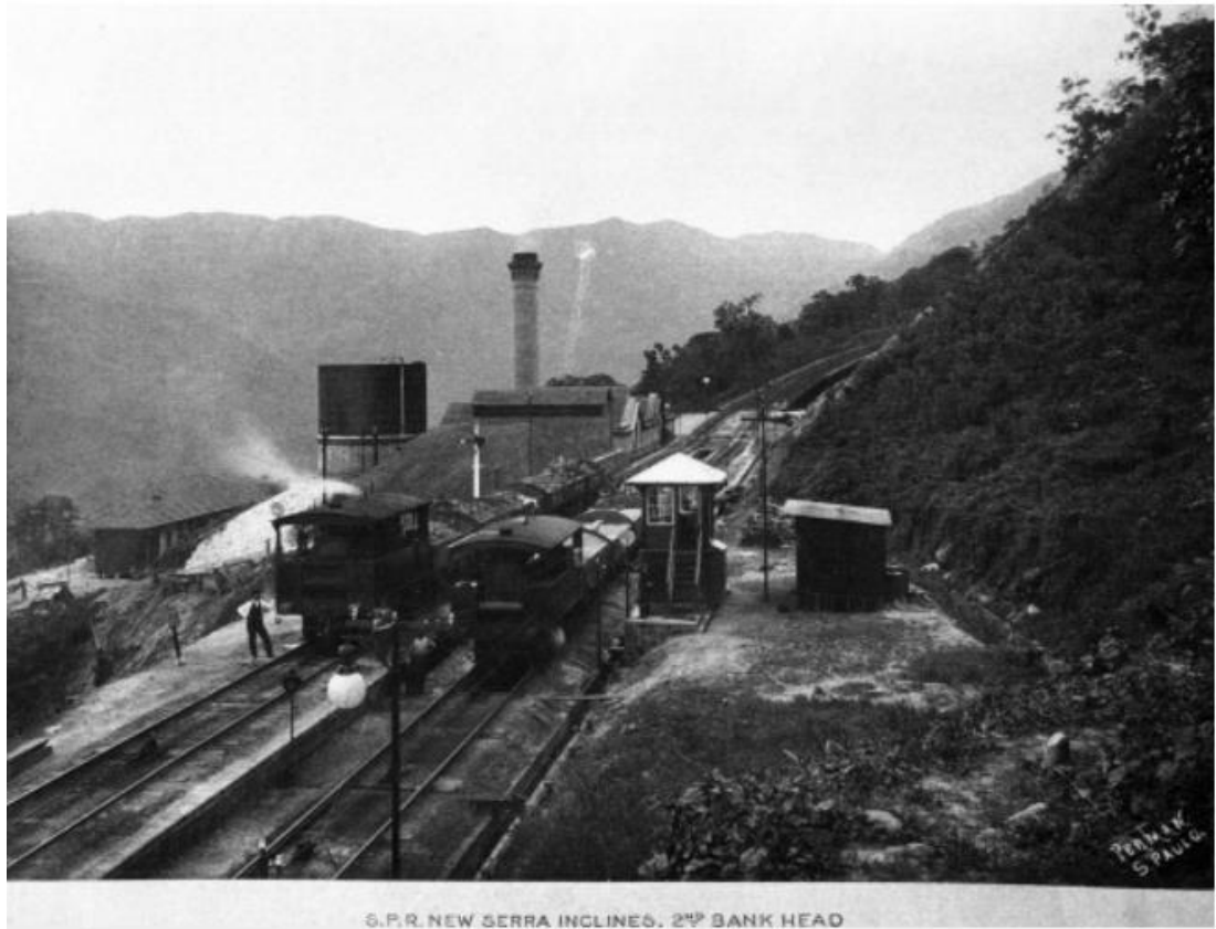
Foto 3 - Segundo Patamar do sistema Serra Nova
