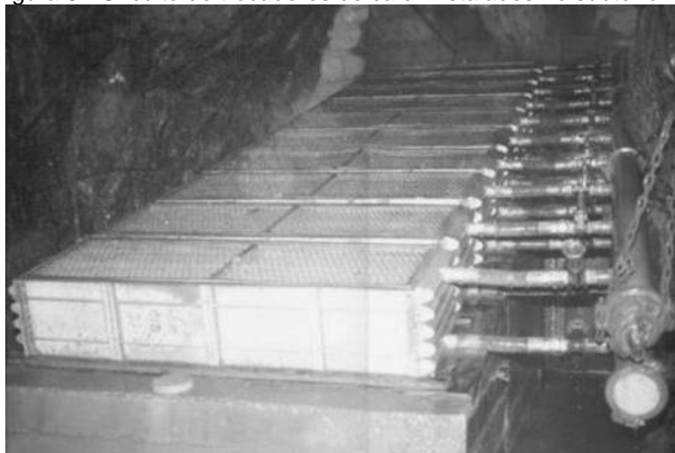
Figura 8 - Circuito de trocadores de calor instalados no subterrâneo
