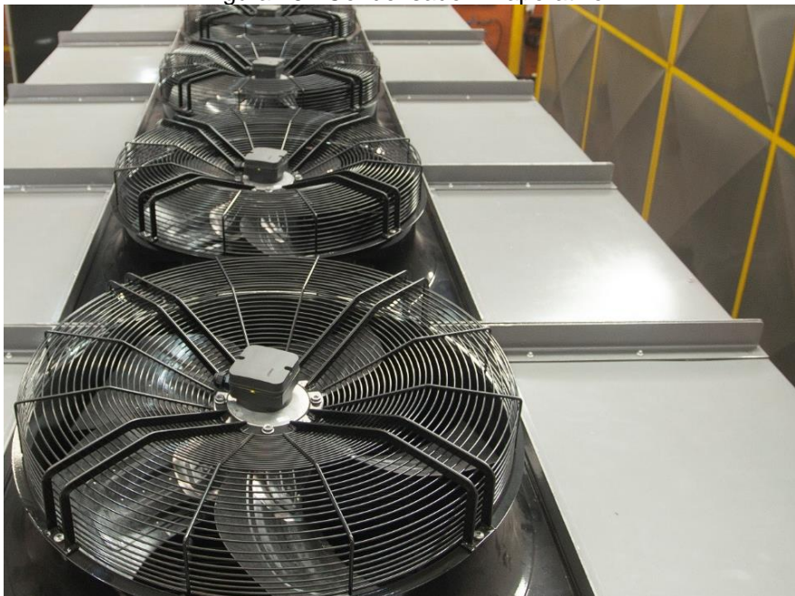
Figura 16 - Condensador Evaporativo
