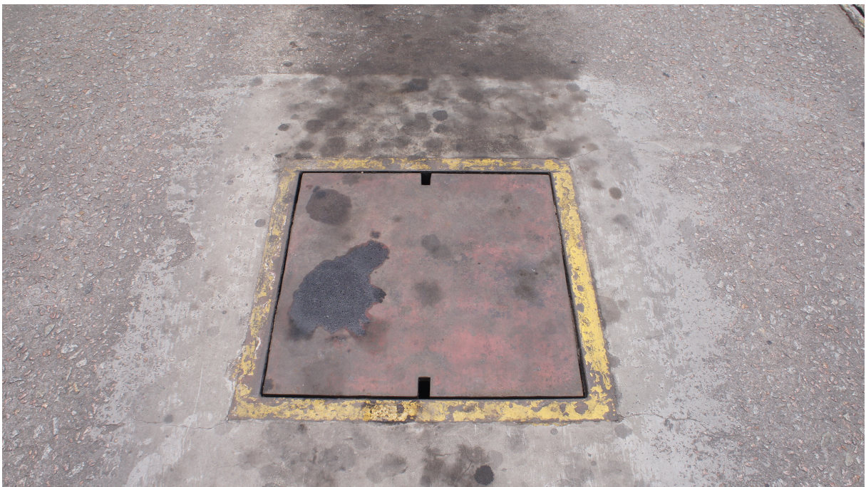
Figura 7 – Detalhe da entrada do espaço confinado
