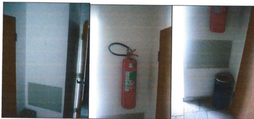
Figura anexo 1- Local sem extintor substituto (em manutenção), sem sinalização, sem quadrado vermelho no chão e com objeto embaixo do extintor
