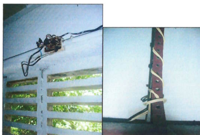
Figura anexo 20-Fiação exposta
