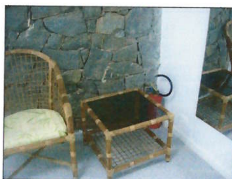
Figura anexo 2-Extintor escondido no chão sem suporte
