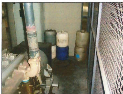
Figura anexo 7-Gerador sem porta corta-fogo, com bombonas de combustível em local impróprio e sem tomada de ar independente
