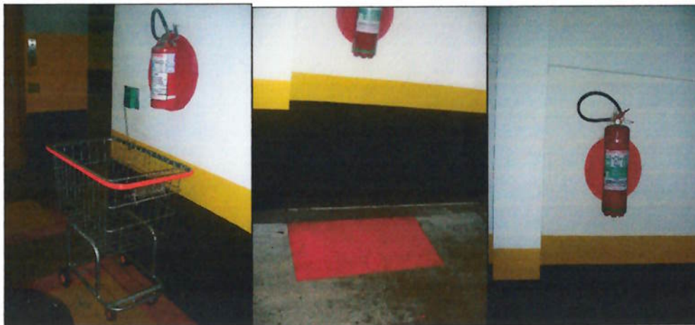
Figura anexo 10-Objeto abaixo do extintor, extintor com altura errada, mal sinalizado, sem sinalização e sem lacre
