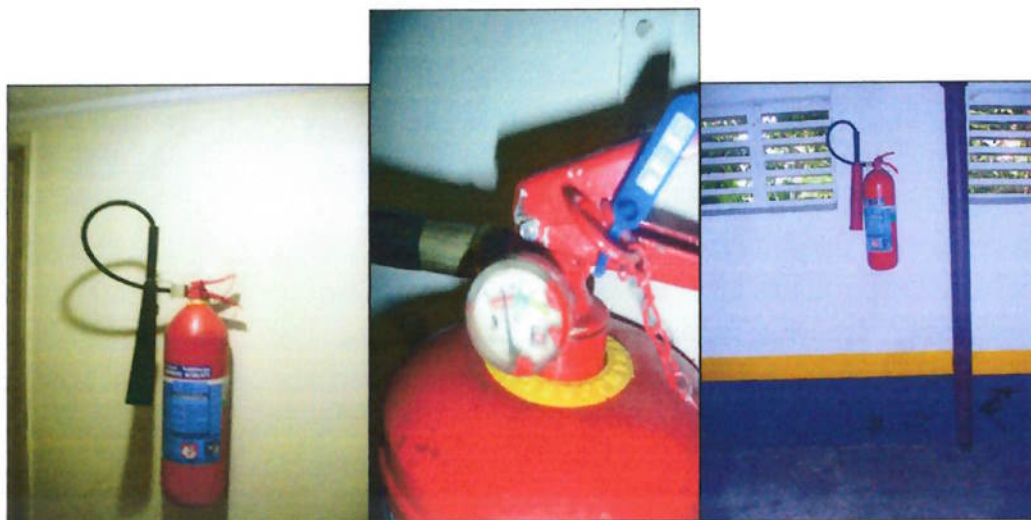
Figura anexo 14-Extintor sem sinalização, com carga vencida, em altura irregular, só tipo b/c
