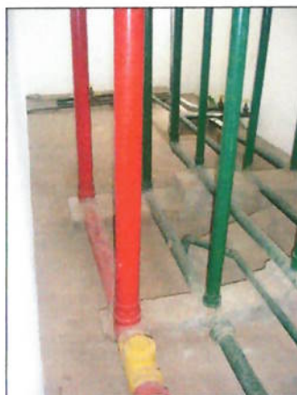
Figura anexo 15-Tubulação de hidrante sem bomba para pontos menos favorecidos
