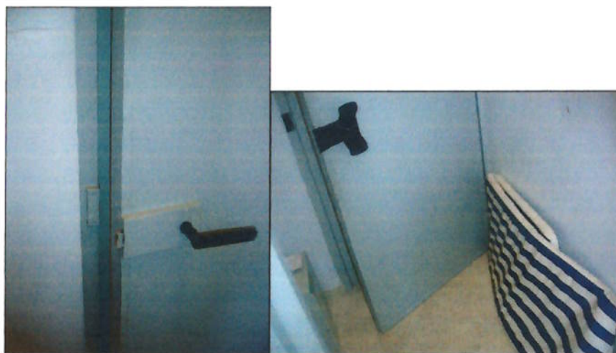
Figura anexo 9-Porta corta-fogo com defeito- não fecha e sem sinalização e com material estranho na rota de fuga
