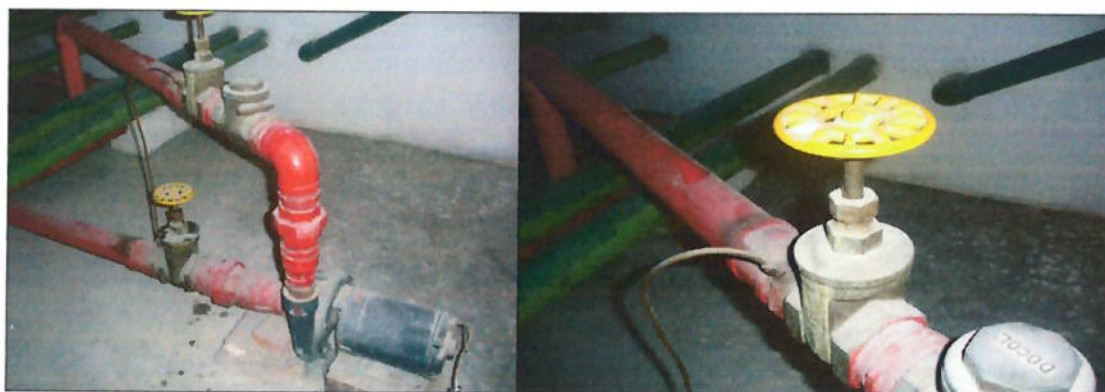
Figura anexo 13-Bomba sem manutenção
