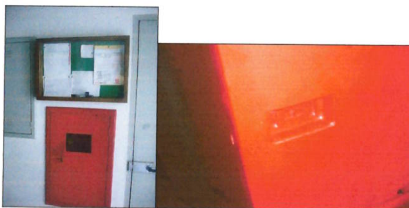
Figura anexo 3-Hidrante sem sinalização com quadro em cima e com trinco quebrado
