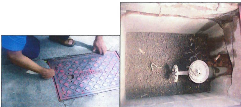
Figura anexo 5-Dificuldade para abrir caixa de recalque, suja e rachada por raiz de árvore
