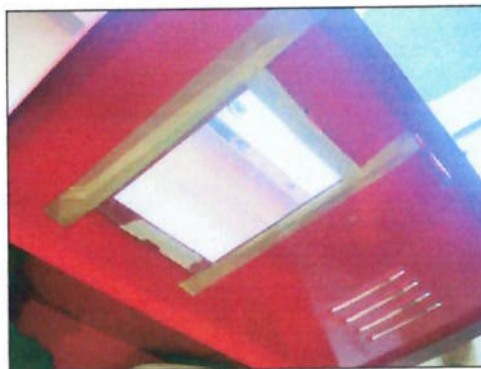
Figura anexo 16-Vidro de inspeção do hidrante colado com fita adesiva
