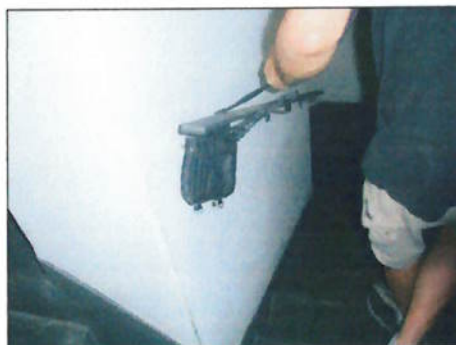
Figura anexo 22-Corrimão sem terminação na parede
