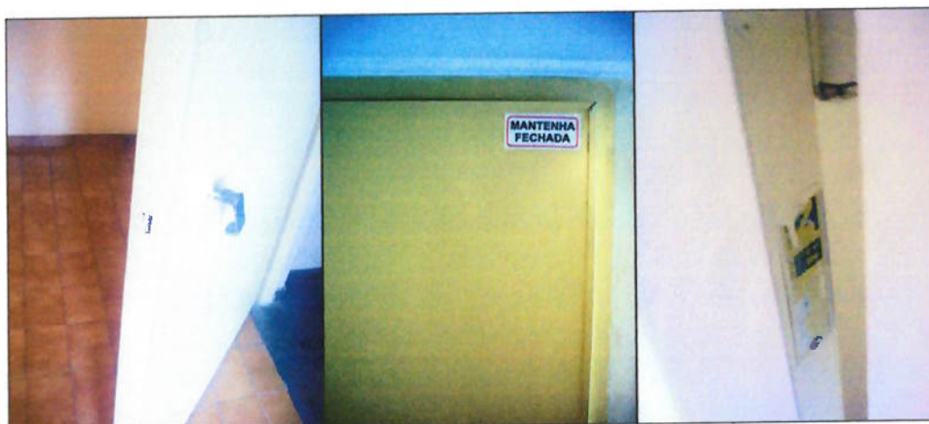
Figura anexo 17-Porta corta-fogo com trinco quebrado, que não fecha, mal sinalizada e sem o selo do fabricante
