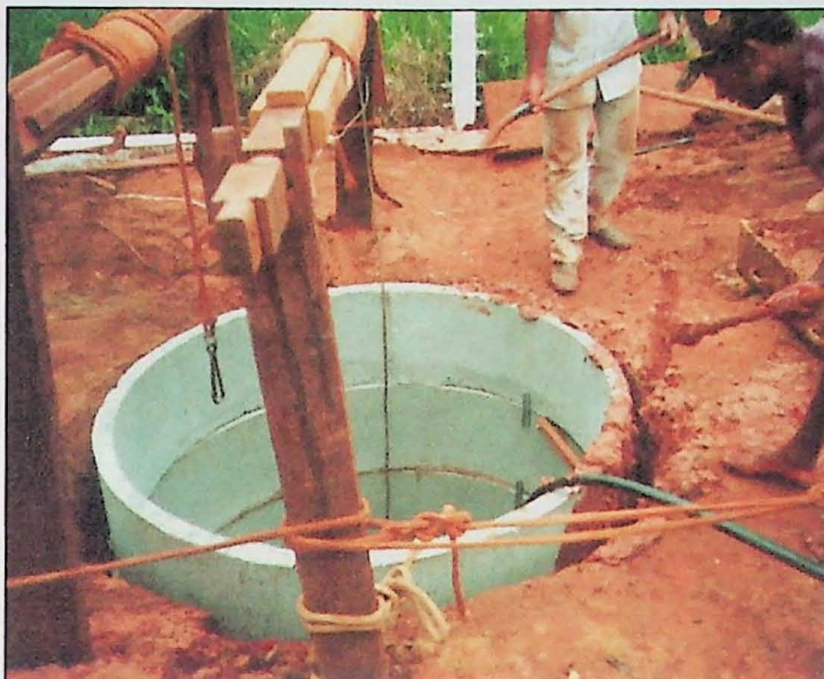
Fotografia 1 – Serviços de colocação de mistura de bentonita com solo de escavação, visando a impermeabilização da parede do poço.
