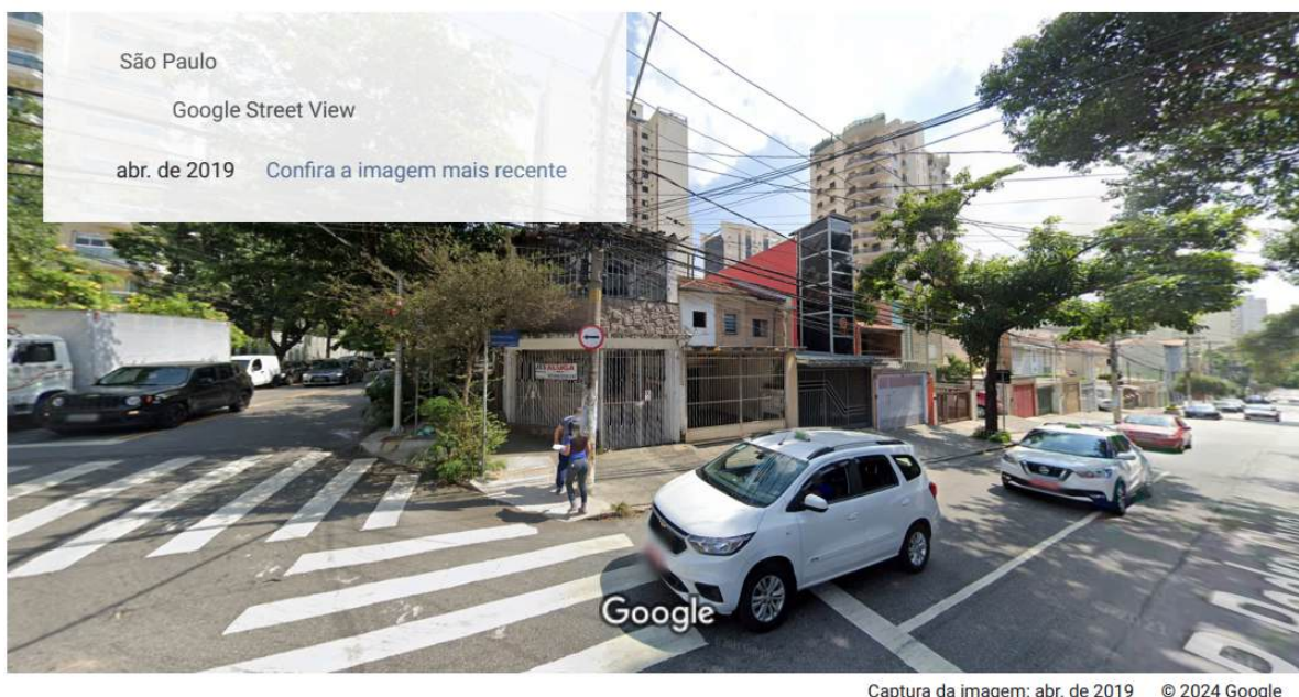
Foto 6: Rua Tucuna X Rua Padre Chico em 2019, antes da incorporação.
