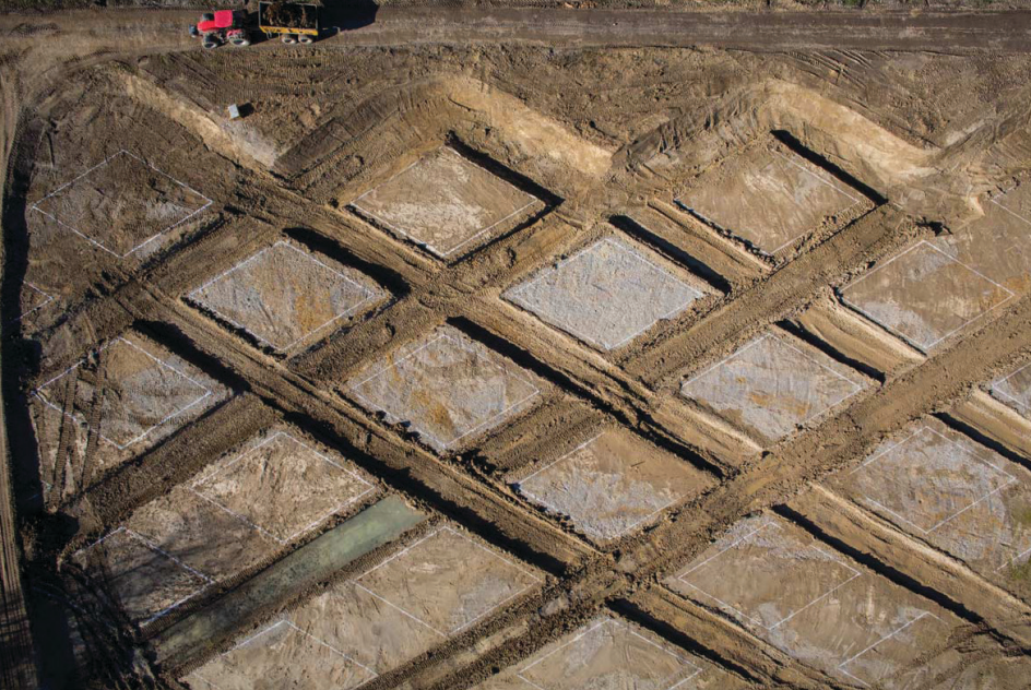
Figura 4 - renaturalização do rio Aire: a malha escavada em formato de diamante
