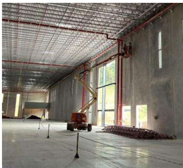
Figura 49 – Fotografia instalação de colunas de alimentação da rede de SPK (Fonte: Autora)
