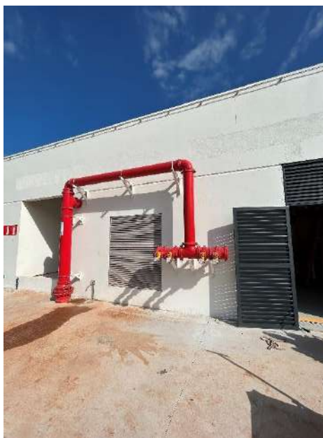
Figura 12 – Ponto de recalque para abastecimento de viatura do Corpo de Bombeiros (Fonte: Autora)
