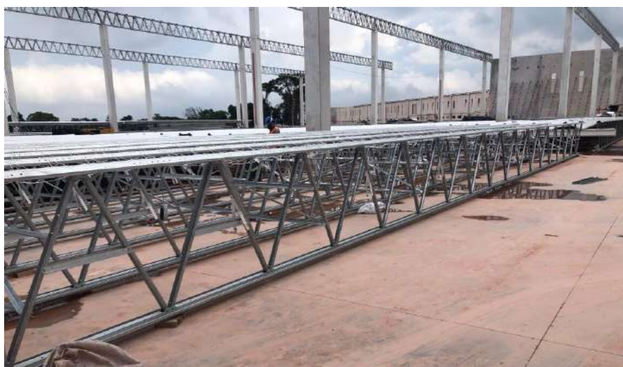
Figura 33 – Fotografia de módulos de cobertura em processo de montagem (Fonte: Autora)
