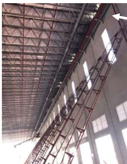
Figura 48 – Fotografia da rede principal de SPK (Fonte: Autora)
