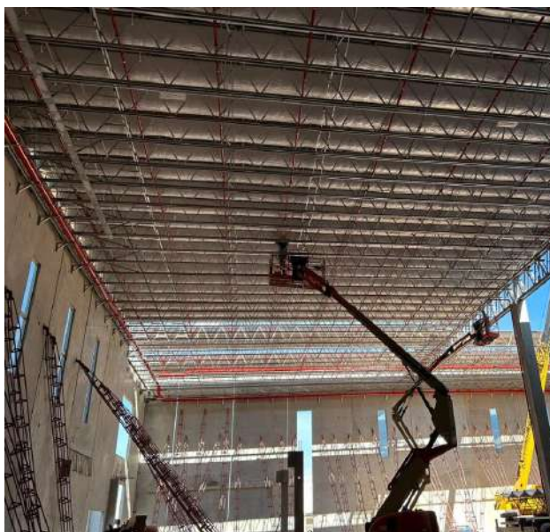
Figura 45 – Fotografia do serviço de fixação e acoplamento de ramais de SPK (Fonte: Autora)
