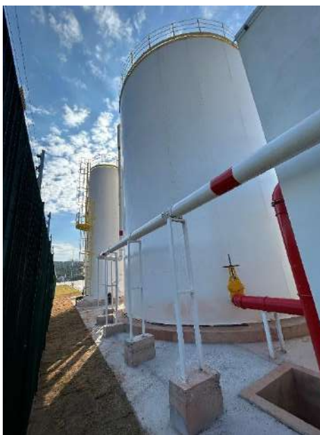
Figura 14 - Reservatório com fundo ao nível do solo (Fonte: Autora)
