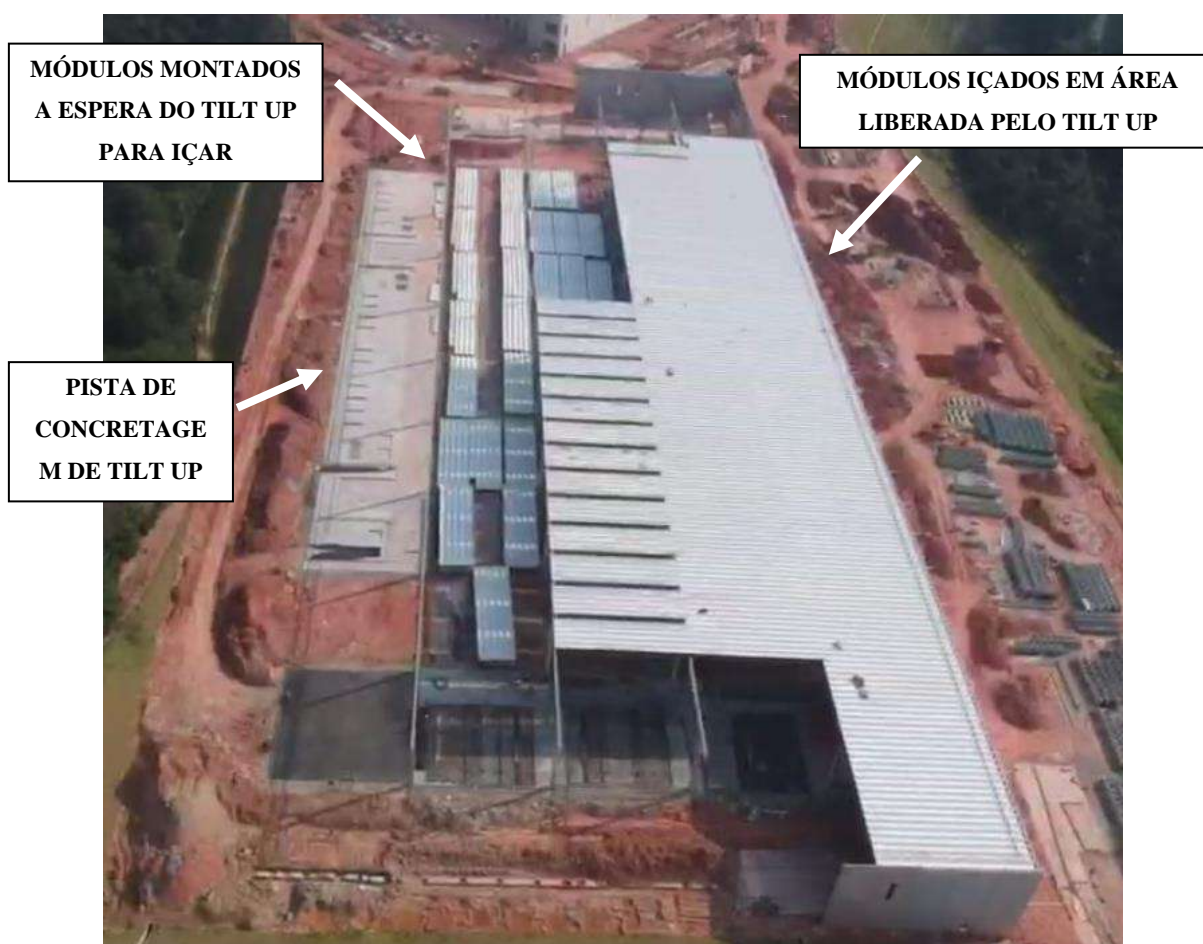
Figura 33 – Fotografia de módulos de cobertura em processo de montagem (Fonte: Autora)
