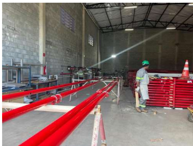
Figura 38 –Pré-montagem de ramais (Fonte: Autora)
