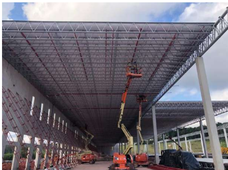
Figura 44 – Fotografia do serviço de içamento de ramais de SPK (Fonte: Autora)
