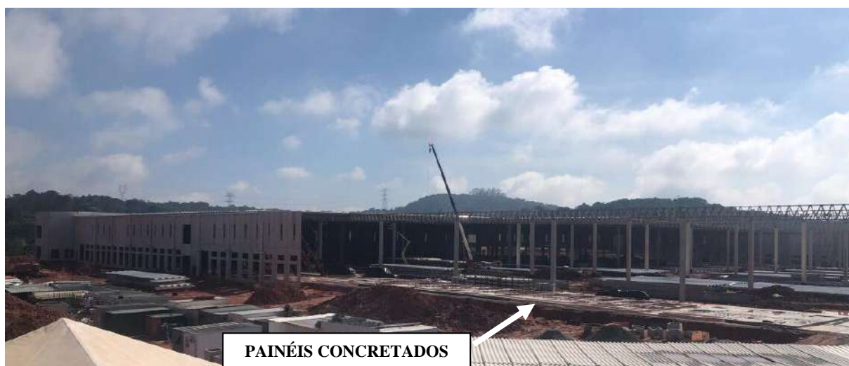
Figura 31 – Fotografia da execução do sistema tilt up (Fonte: Autora)
