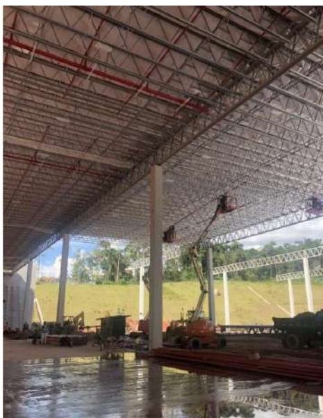
Figura 43 – Fotografia do serviço de içamento de ramais de SPK (Fonte: Autora)
