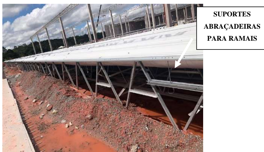
Figura 42 – Suportes para ramais de SPK (Fonte: Autora)
