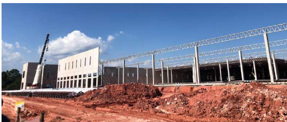
Figura 31 – Fotografia da execução do sistema tilt up (Fonte: Autora)
