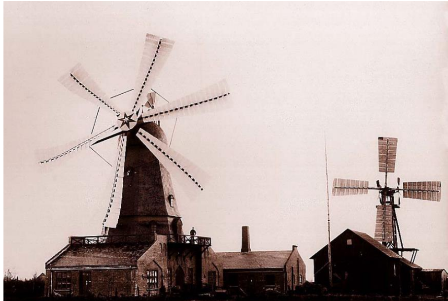
Figura 3: Turbinas de teste desenvolvidas por Poul la Cour em 1897, Askov, Dinamarca
