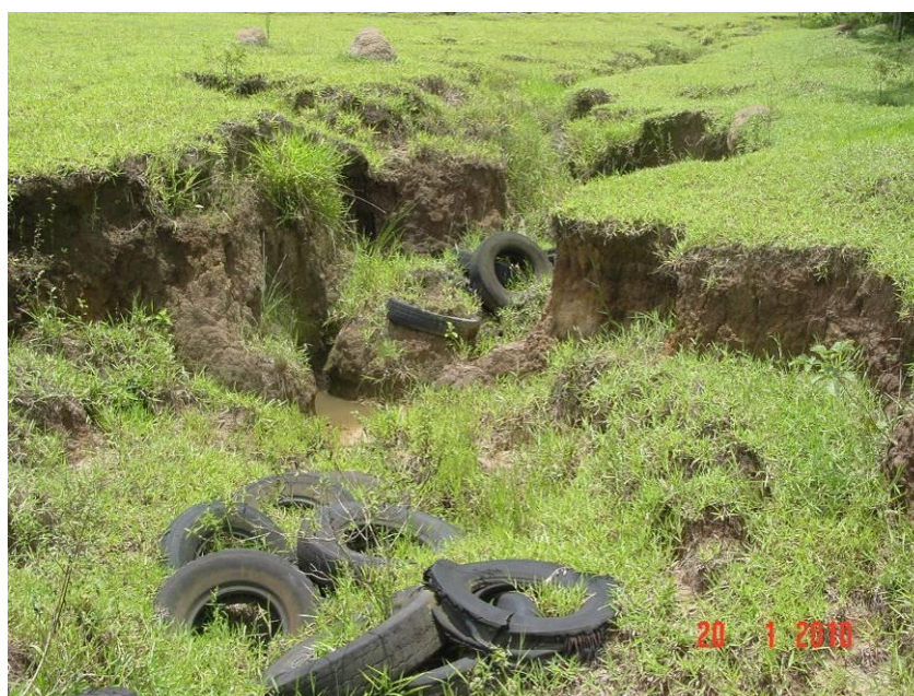
Figura 10: Boçoroca com medida paleativa de contenção.
