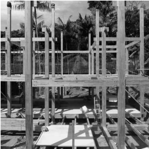
Canteiro Sede Fundação Florestal. Fonte: 23 SUL
