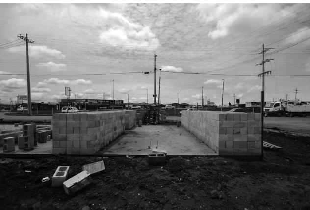
Construção paredes, primeiro empilhamento de blocos, Avaré, 2016. Foto Vão
