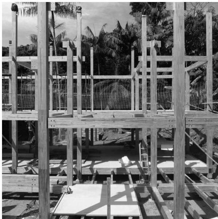
Construção estrutura, Jureia Itatins, 2019. Foto: 23 SUL
