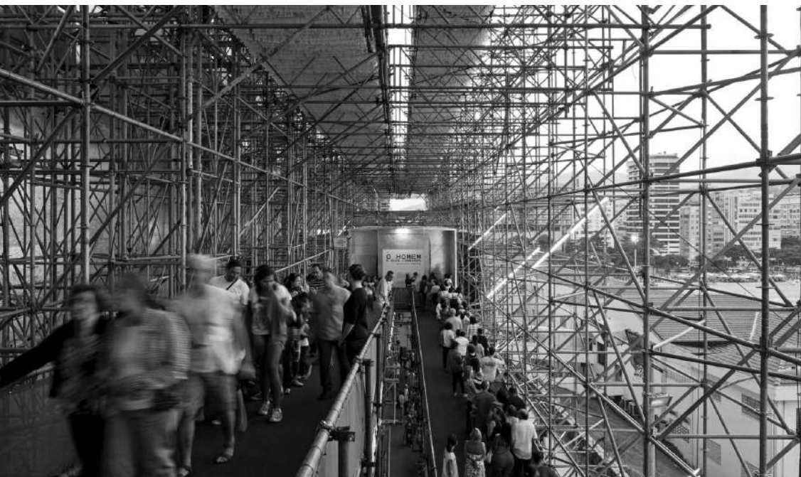
Rampas de acesso Pavilhão Humanidade, Rio de Janeiro, 2012. Foto Leonardo Finotti
