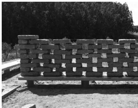
Processo de construção, Itupeva, 2017. Foto cortesia MessinaRivas
