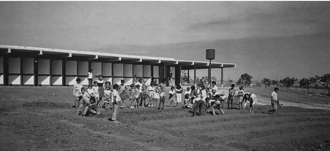
Escola Transitória de Argamassa Armada, Instituto Lina Bo Bardi e P.M. Bardi
