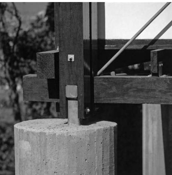
Detalhe encaixe fundação - estrutura, Nelson Kon
