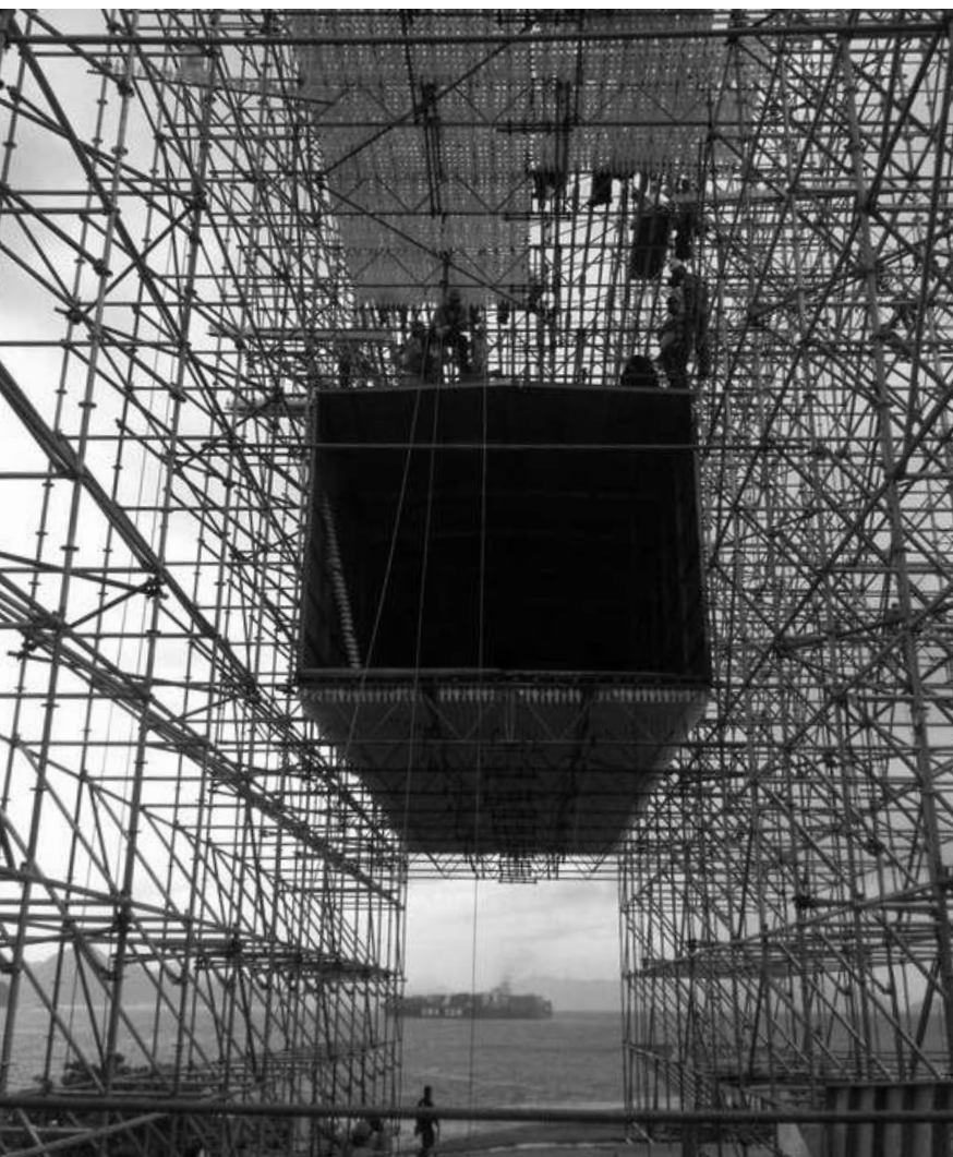
Pavilhão em fase de montagem, 2012. Foto cortesia Carla Juaçaba + Bia Lessa
