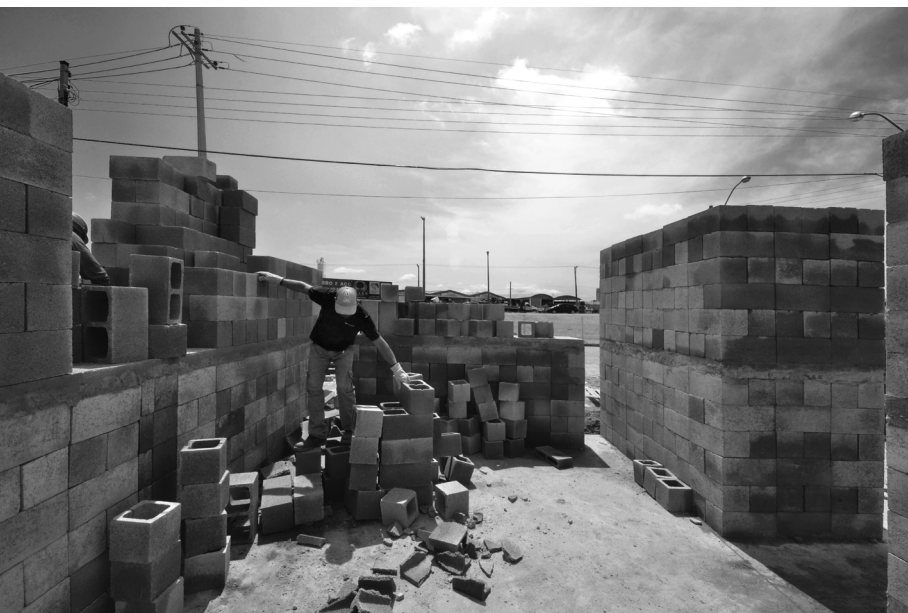
Obra Sede para Fábrica de Blocos, Avaré, 2016. Foto Vão
