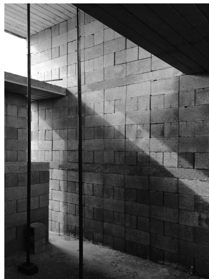
Obra Sede para Fábrica de Blocos, Avaré, 2016. Foto Vão
