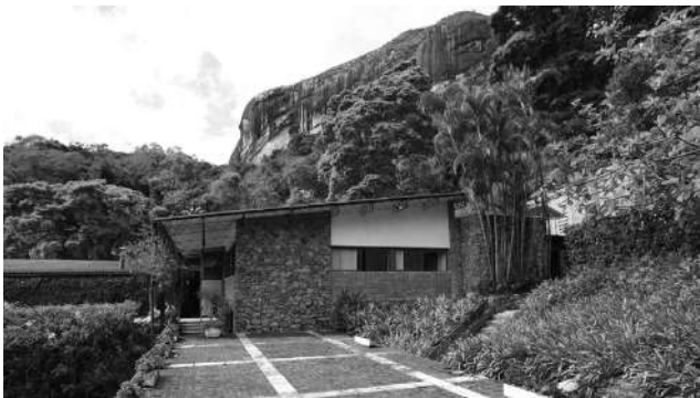
Fachada Sudoeste vista desde a laje de cobertura do abrigo de carros. Acervo Pesquisa Casas Brasileiras.
