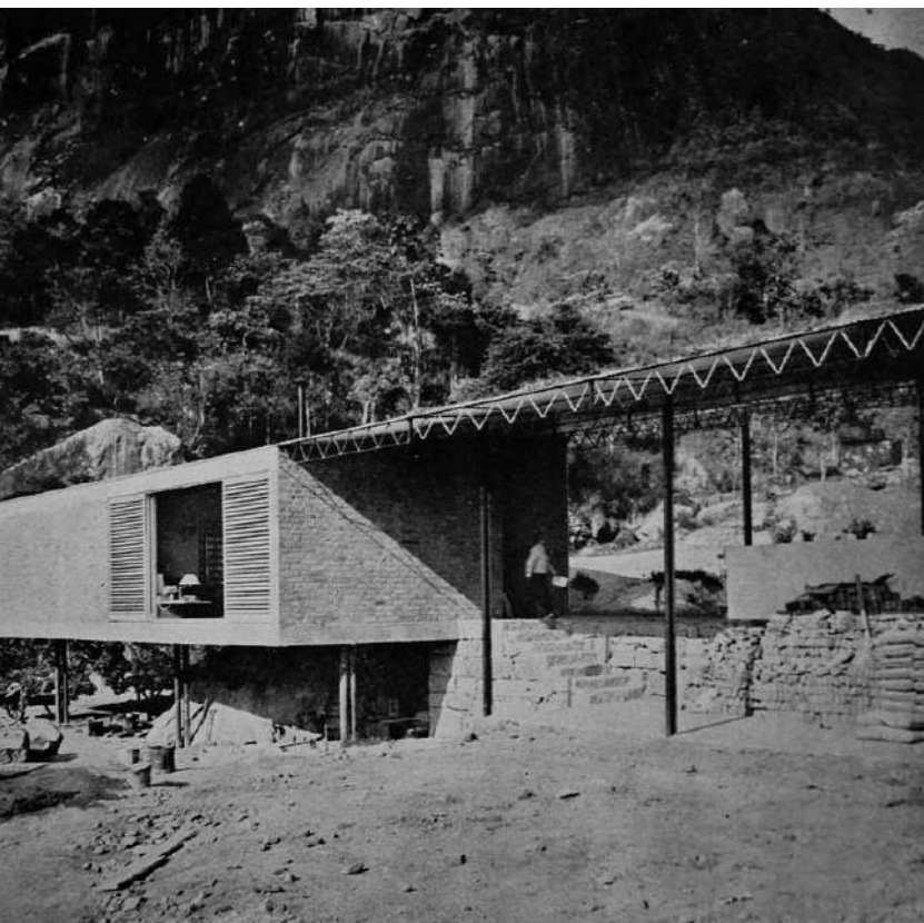
Fachada Noroeste galerias em construção. Revista L'Architecture d'aujourd'hui, n.49, oct. 1953.
