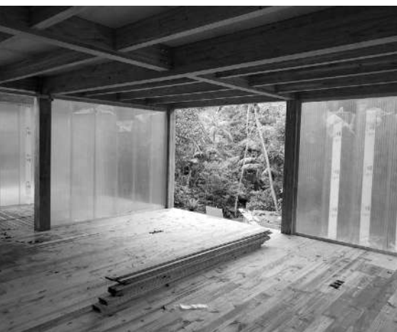
Montagem Paineis em policarbonato Jureia Itatins, 2019. Foto: 23 SUL
