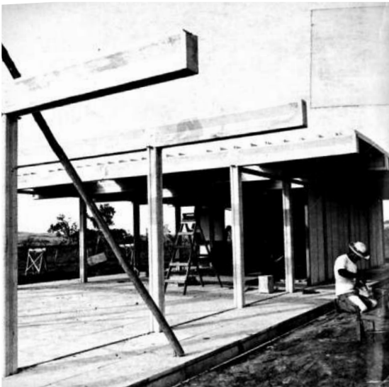
Foto do processo de montagem. Fonte: Manual CEDATE
