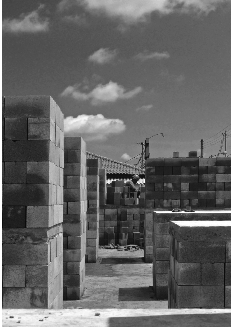
Empilhamento dos blocos, Avaré, 2016. Foto Vão
