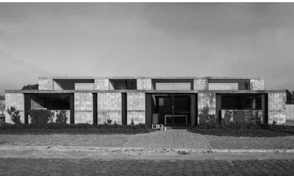
Vista frontal Sede para Fábrica de Blocos, Avaré, 2016. Foto Raffaella Neto
