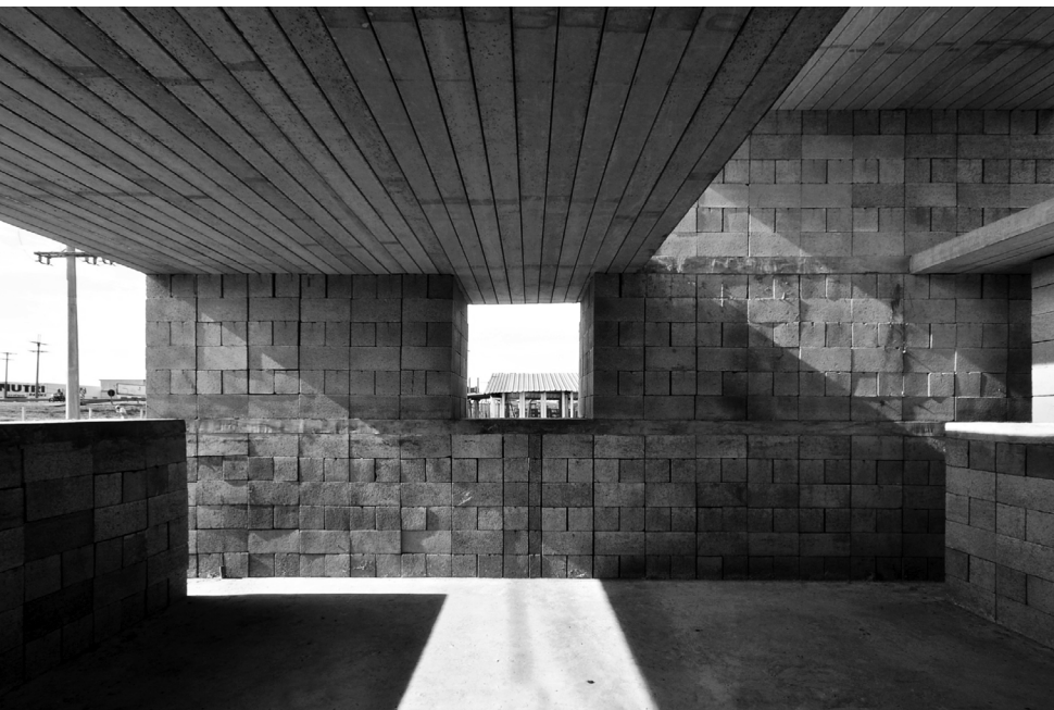
Vista interna durante a obra, Avaré, 2016. Foto Vão
