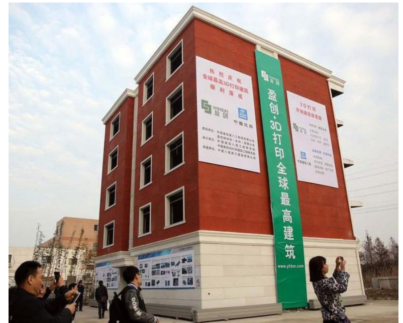
Figuras 145, 146 e 147: Edifício executado com tecnologia de impressão 3D em concreto pela WinSun, Parque Industrial de Suzhou, na China. Esse é o edifício mais alto do mundo construído através dessa tecnologia.
