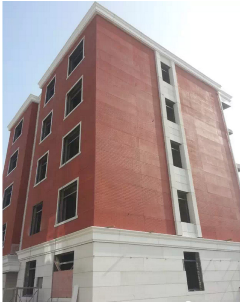
Figuras 145, 146 e 147: Edifício executado com tecnologia de impressão 3D em concreto pela WinSun, Parque Industrial de Suzhou, na China. Esse é o edifício mais alto do mundo construído através dessa tecnologia.
