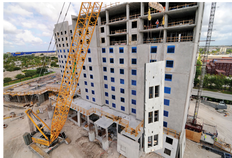
Figuras 132 a 134: O sistema construtivo “tilt-up” consiste em executar as paredes na horizontal, erguendo-as depois de pronta.
