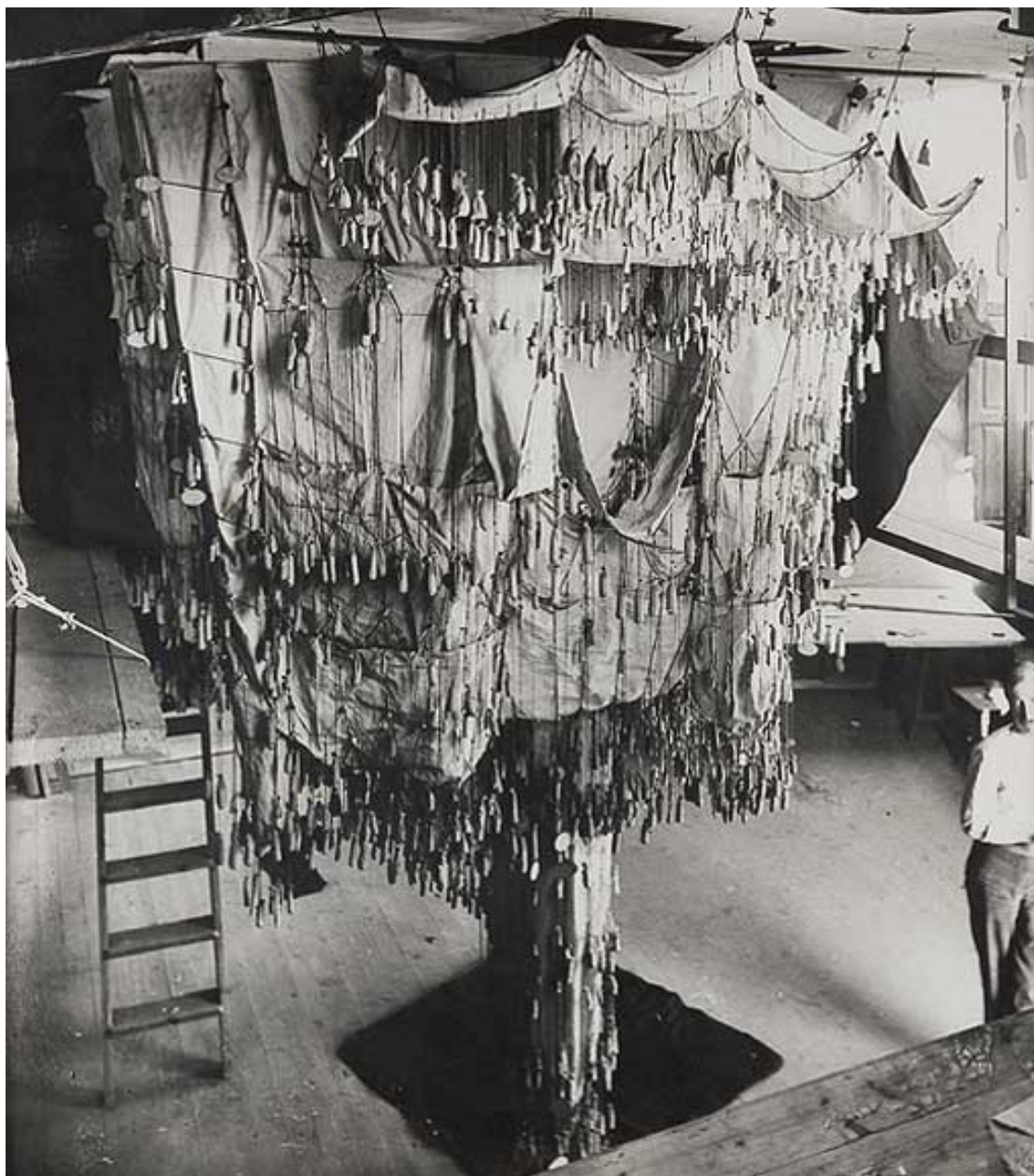
Figura 26: O modelo anti funicular de Antoni Gaudí durante o estudo da capela Colônia de Güell pendurado em sua oficina. O modelo revestido em papel foi construído com a ajuda do engenheiro Edoud Goet.
