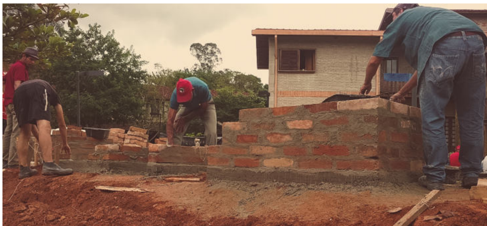
Figura 71 - Assentamento de blocos da arquibancada pelos Trabalhadores Aprendizes Voluntários. Fonte: Caetés, 2017
