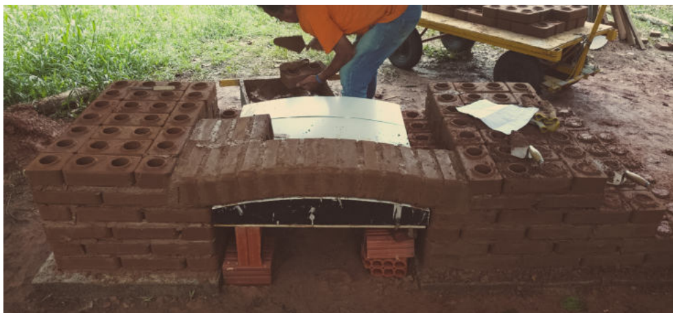
Figura 27 - construção do arco com BTC sobre o gabarito de apoio. Fonte: Caetés, 2017
