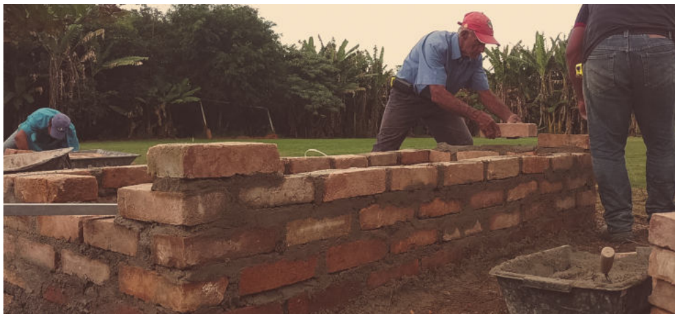
Figura 72 - Assentamento de blocos da arquibancada. Fonte: Caetés, 2017
