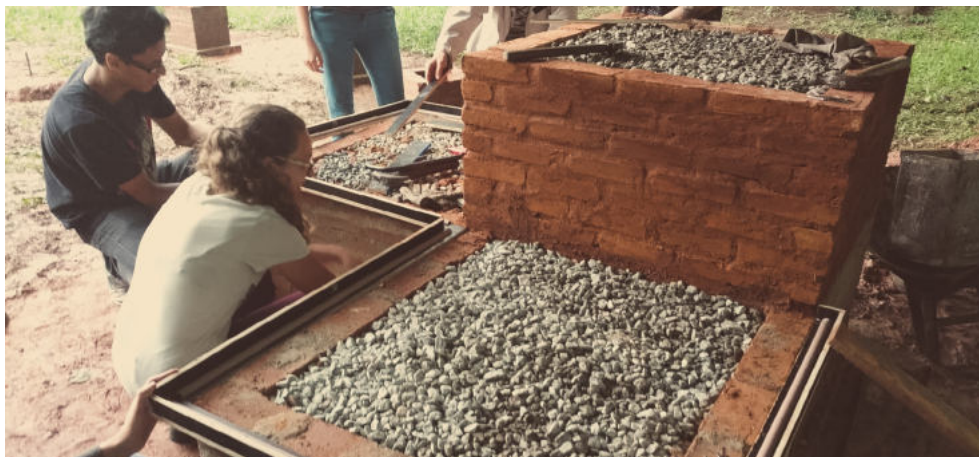
Figura 24 - Preenchimento do interior do módulo cubo com terra e brita; montagem de fôrmas para os assentos. Fonte: Caetés, 2017
