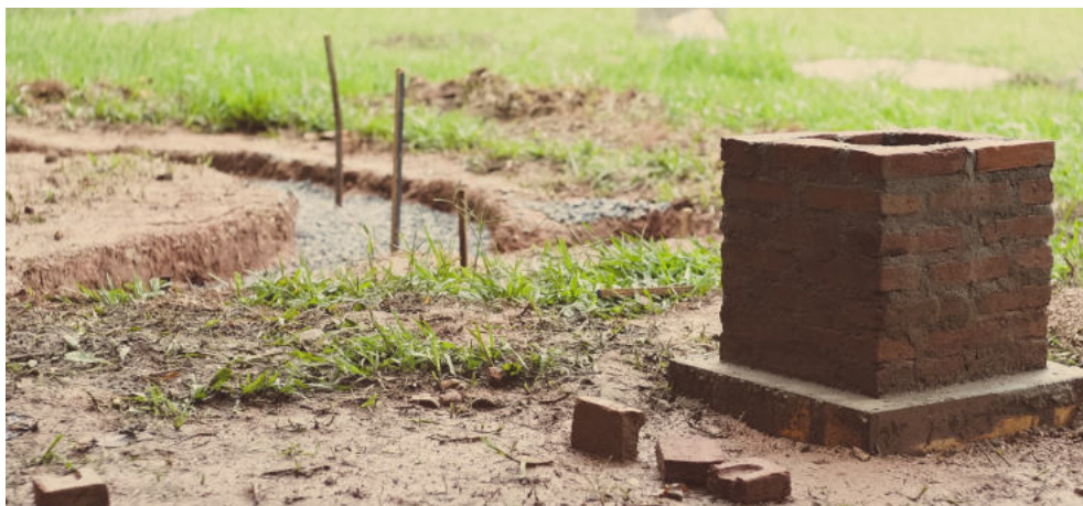
Figura 13 - Um dos três pilares de apoio do módulo três apoios. Fonte: Caetés, 2017
