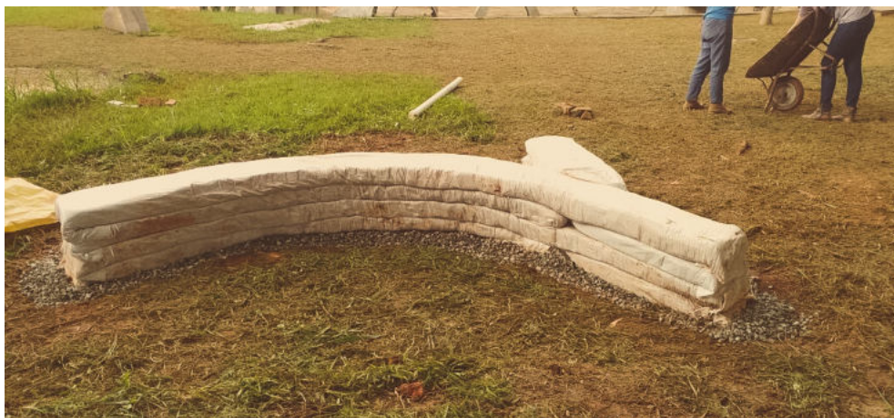
Figura 21 - Módulo do hiperadobe finalizado, sem revestimento. Fonte: Caetés, 2017
