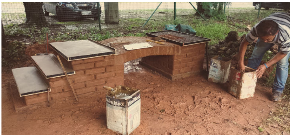
Figura 28 - Montagem e concretagem das formas para os assentos do módulo arco. Fonte: Caetés, 2017
