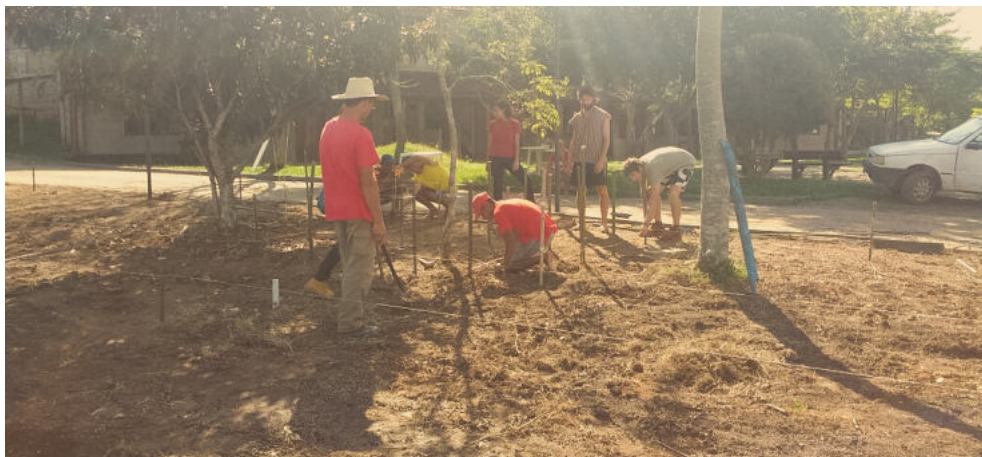
Figura 60 - Oficina com piquetes de bambu e linhas de barbante. Representação de volumetria da arquibancada. Fonte: Caetés, 2017
