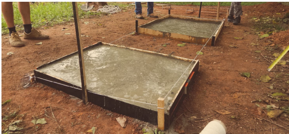
Figura 26 - Montagem e concretagem das fôrmas para fundação do módulo arcos. Fonte: Caetés, 2017
