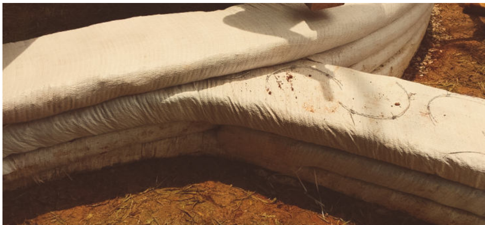
Figura 20 - Fiadas de saco de ráfia, com arame farpado entre elas, preenchidas com terra e piladas. Fonte: Caetés, 2017
