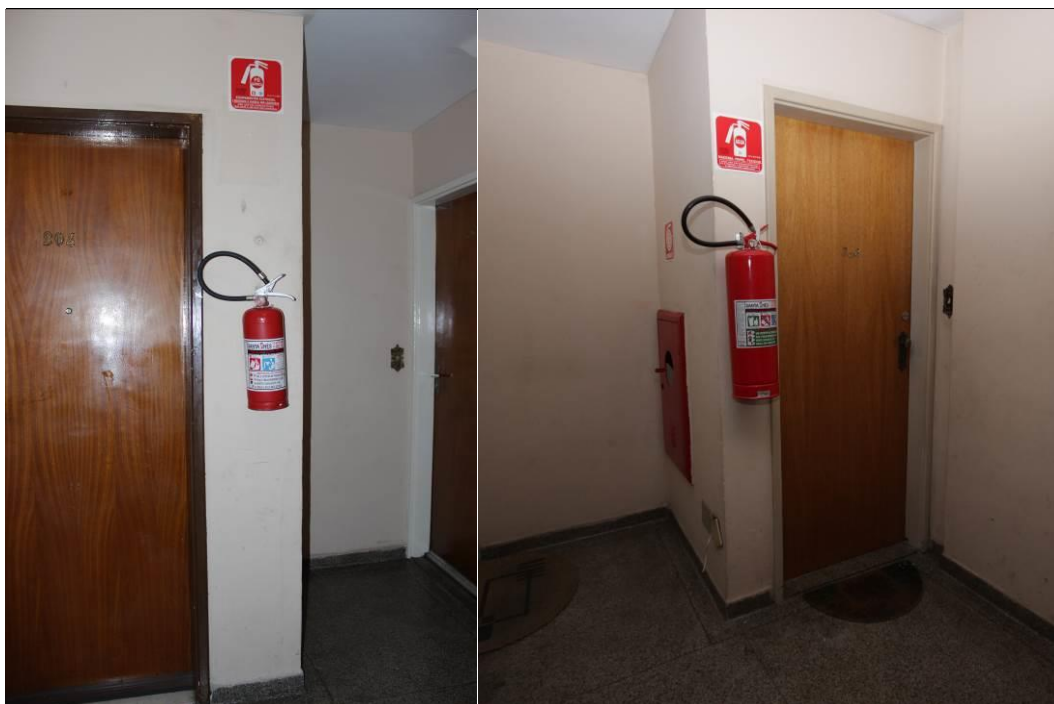
Figura 4-1: Unidades extintoras dos pavimentos de apartamento
