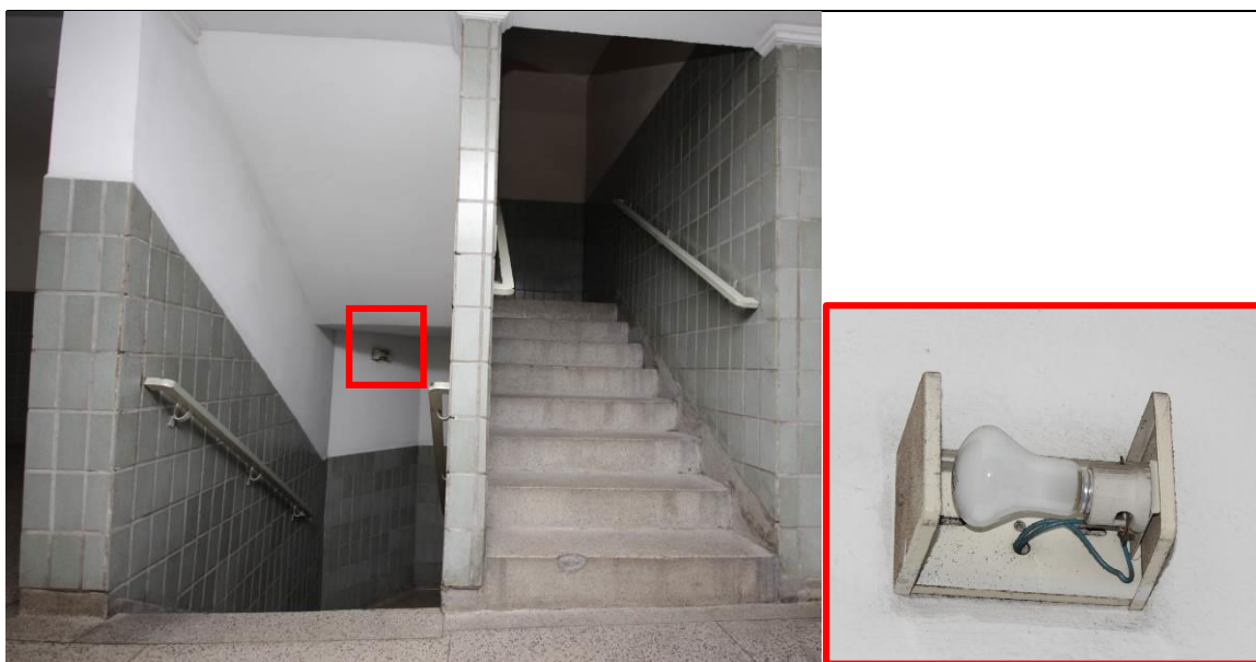
Figura 4-2: Sistema de iluminação de emergência Fonte: Arquivo Pessoal
