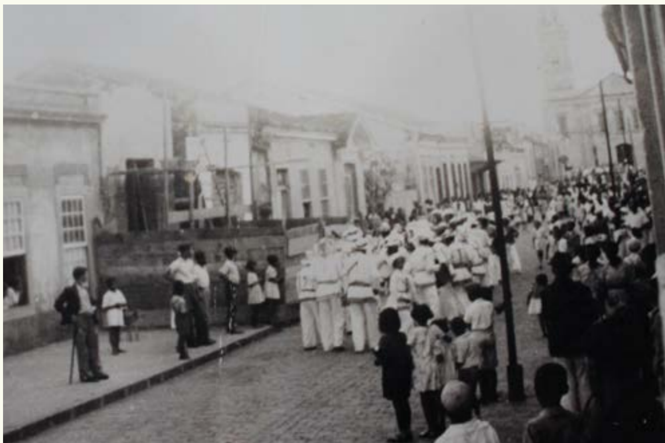
Figura 16 Leito carroçável em paralelepípedo, destaque para as congadas e para o andaime na reforma de uma edificação. Fonte: Museu João Batista Conti.
