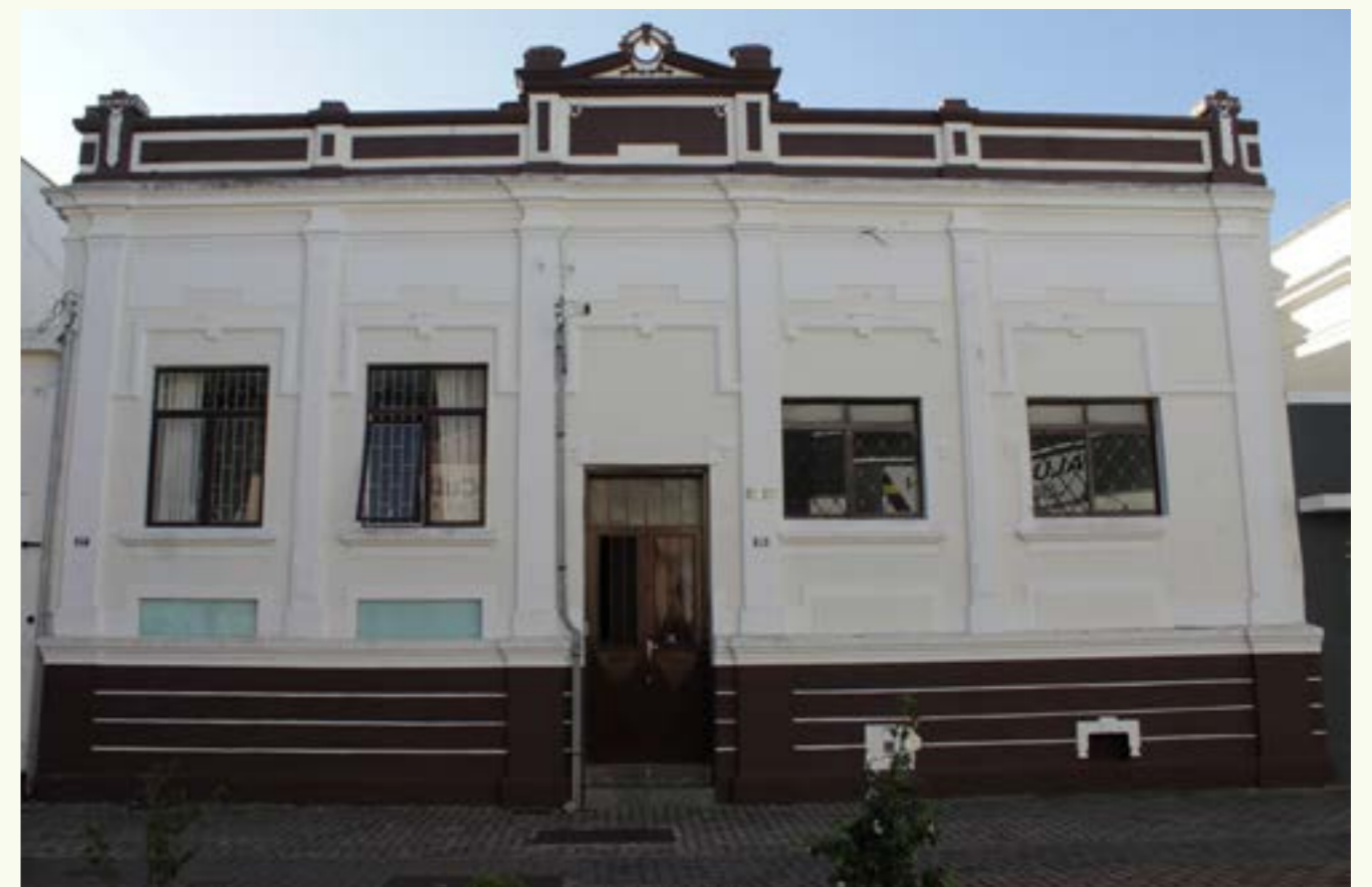
Figura 35: O prédio atualmente. Autoria própria, 2024.
