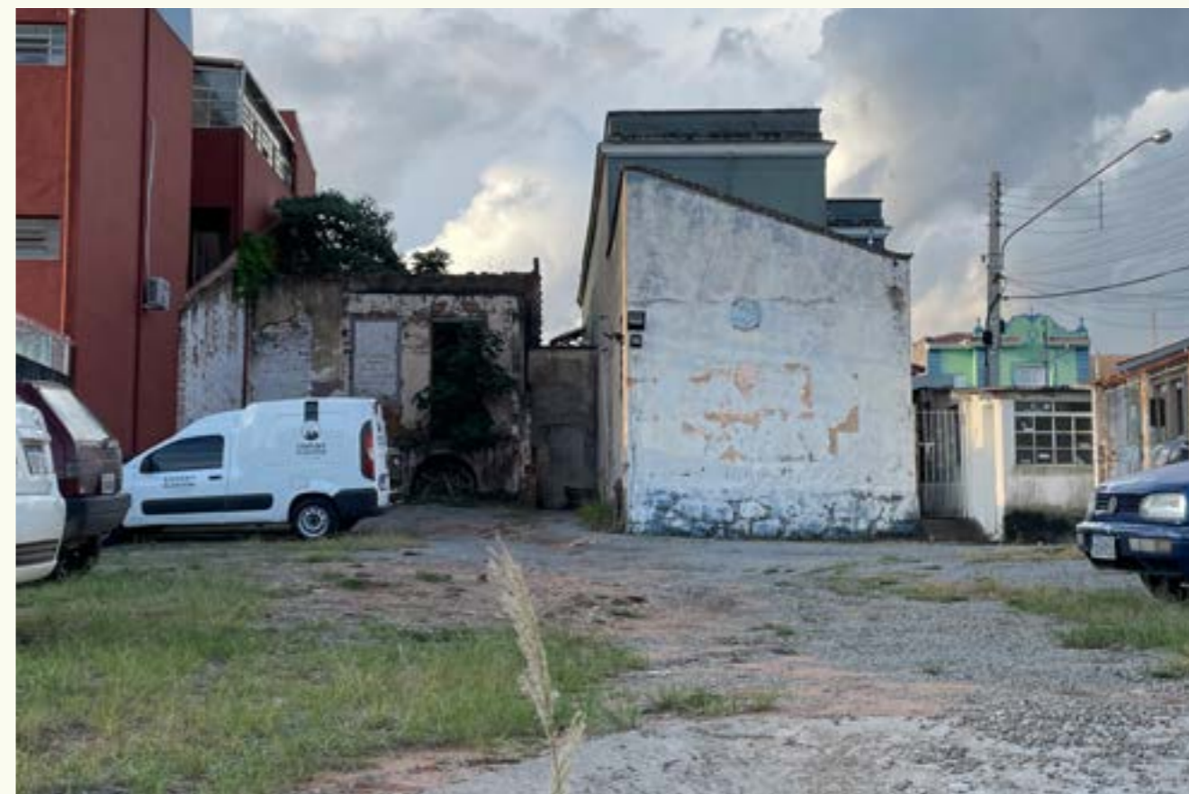
Figura 41: Fundo do lote da casa em ruínas. Autoria própria. 2025.
