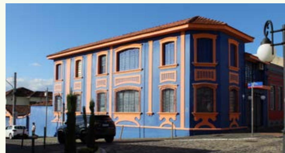
Figura 47: Casa Paroquial com pintura atual. Fonte: Autoria própria. 2025.
