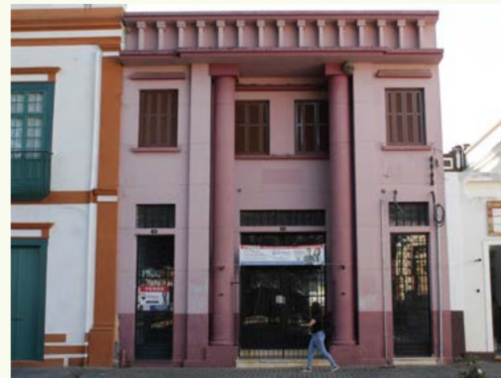
Figura 33: O prédio atualmente, disponível para venda. Fonte: autoria própria. 2025.
