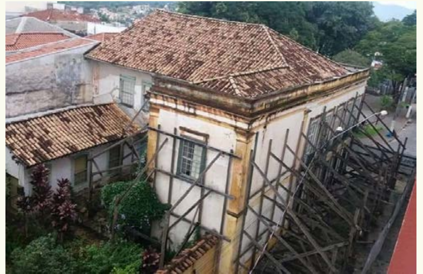
Figura 23: Sobrado Júlia Ferraz com escoramento. Fonte: Grupo Ruas de Atibaia. Publicado em 18 de maio de 2024.
