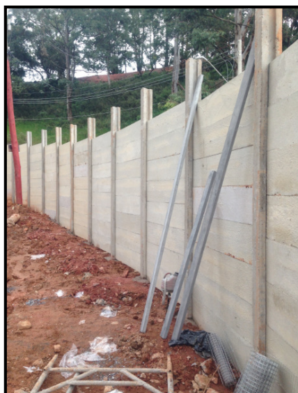
Figura 25 - Face interna do muro
