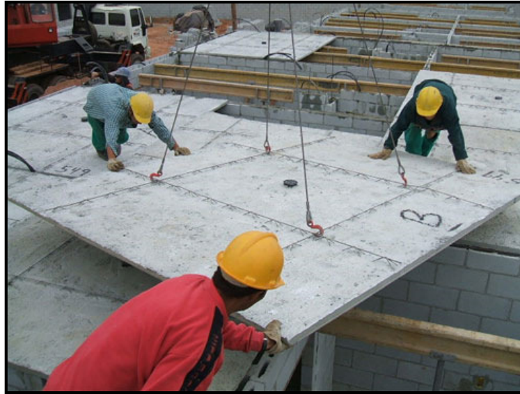
Figura 10 - Pré-laje de concreto Fonte: M3SP
