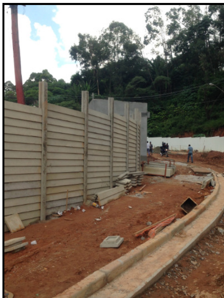
Figura 26 - Face externa do muro
