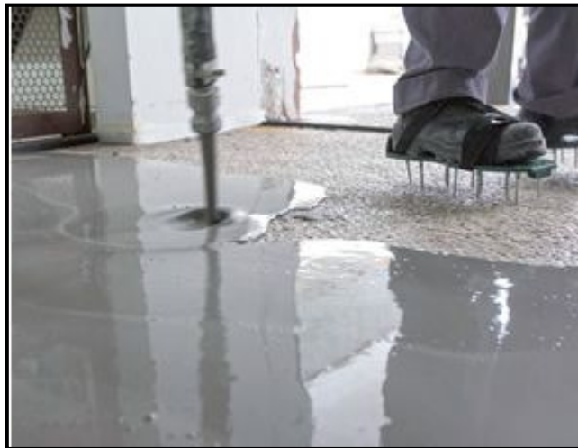
Figura 13 - Contrapiso autonivelante Fonte: Técnica, 2012
