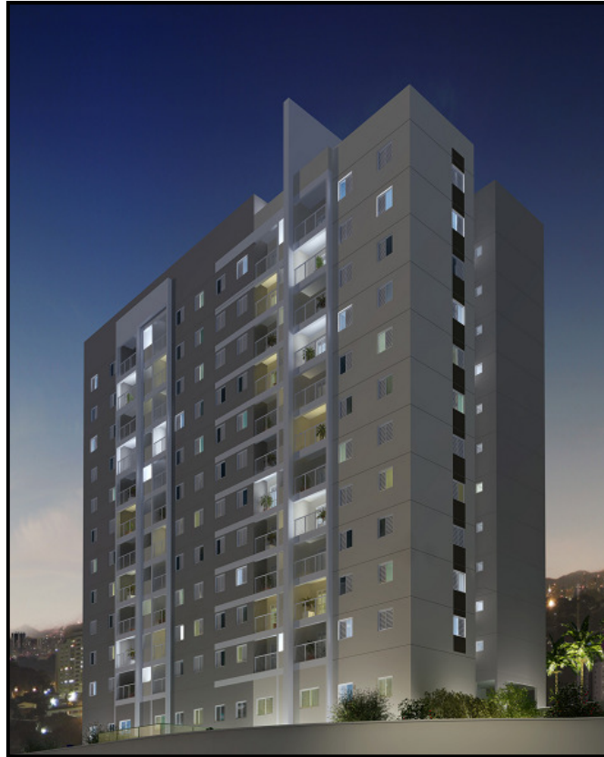
Figura 15 - Fachada de uma torre do Empreendimento A
