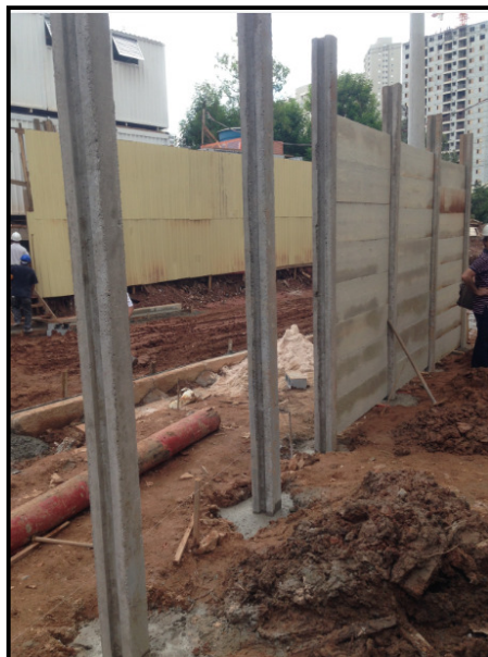
Figura 24 - Concretagem dos mourões de concreto no solo
