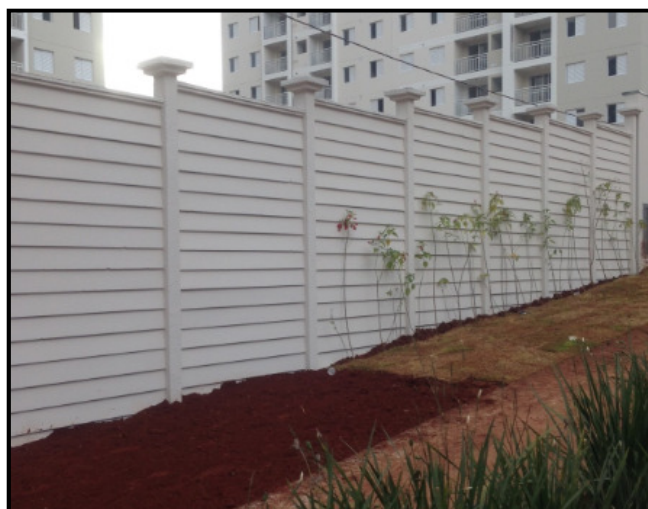
Figura 23 - Muro pré-fabricado em concreto pronto
