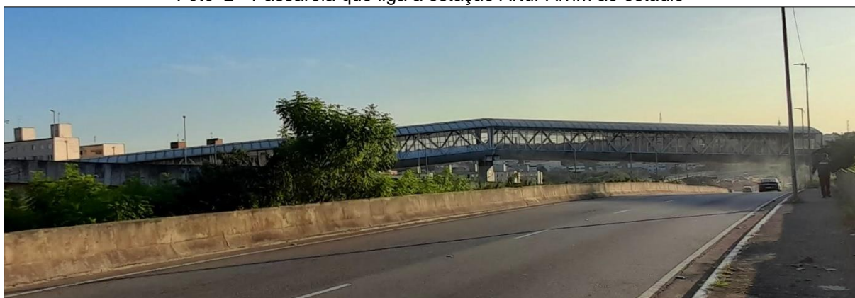
Foto 2 - Passarela que liga a estação Artur Alvim ao estádio
