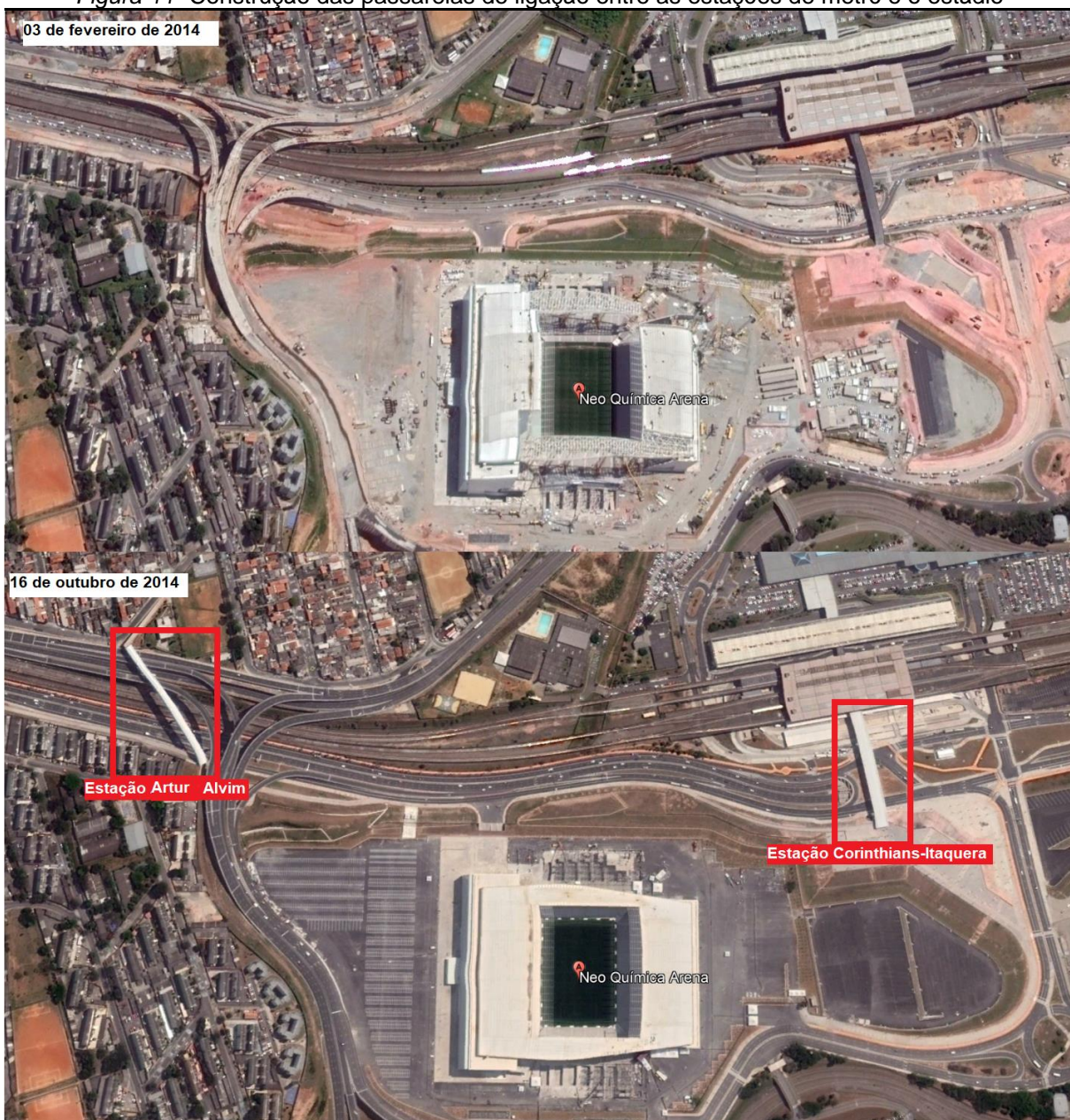
Figura 11- Construção das passarelas de ligação entre as estações de metrô e o estádio
