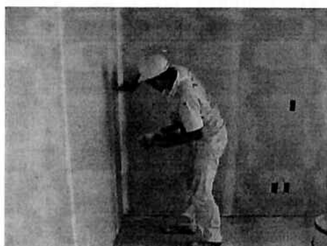
Figura 2.10 – Aplicação do rejunte
