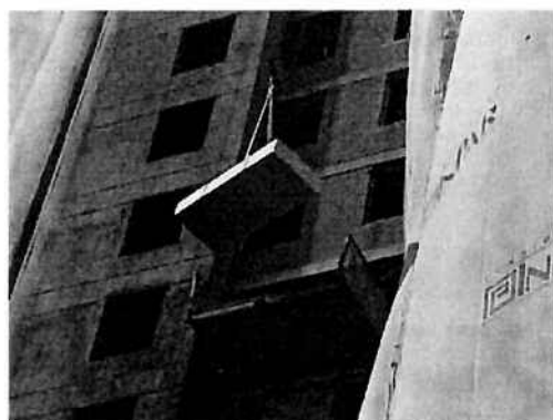
Figura 3.4 - Plataforma colocada no pavimento de desembarque do material içado pela grua.
