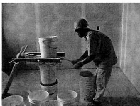
Figura 2.9 - Preparação da massa de rejunte e embebimento da fita para aplicação.
