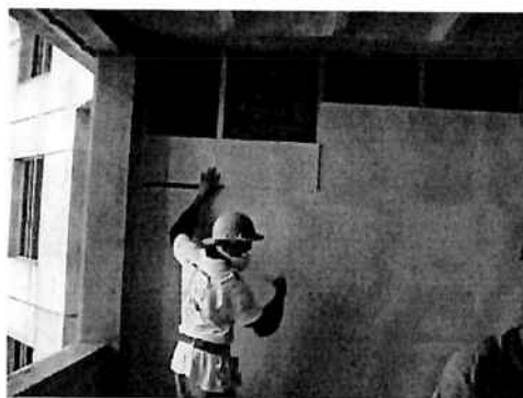
Figura 2.7 - Colocação da 1ª camada de fechamento de uma parede de chapa dupla.
