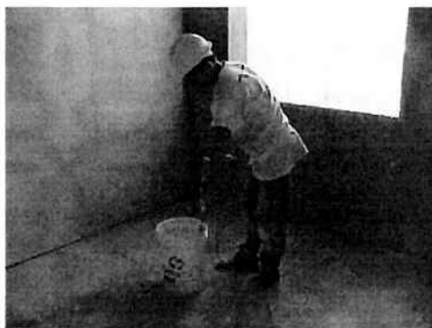
Figura 2.8 – Preparação da massa para o rejunte
