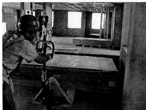
Figura 3.6 - Posicionamento dos páletes de chapas de gesso, seguindo um croqui de armazenamento, que evita a colocação de páletes em regiões onde passam eixos e marcação de paredes.
