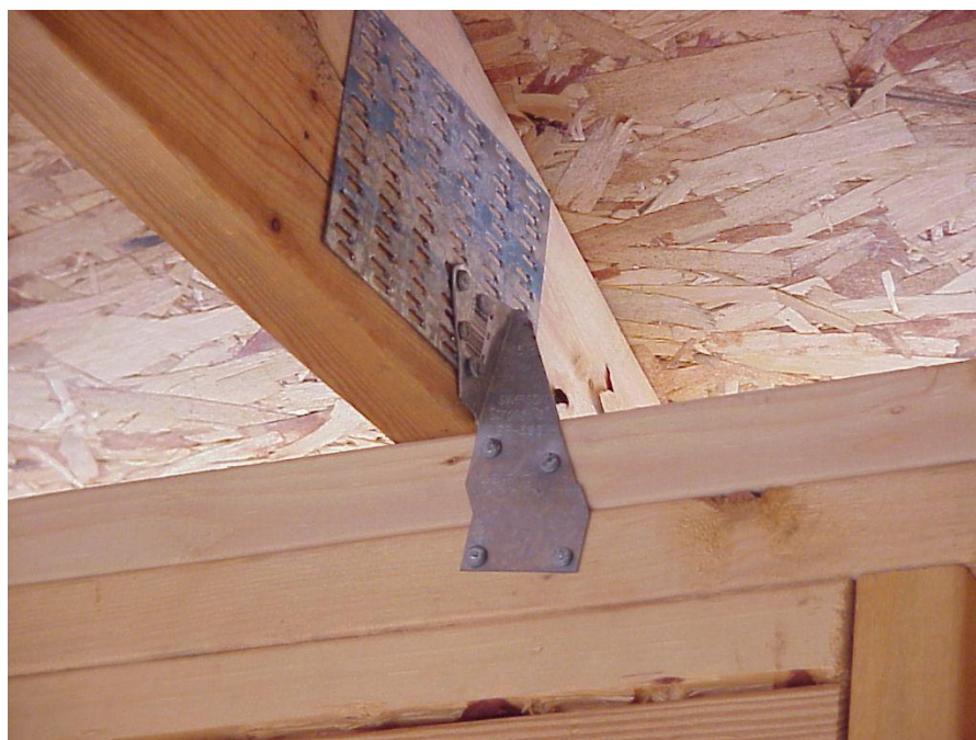
Figura 84 - Detalhe de ligação do telhado com a estrutura
