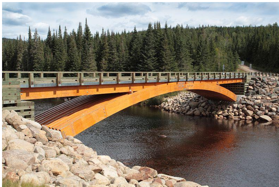
Figura 9 - Ponte em estrutura de madeira laminada colada sobre o Rio Montmorency, Québec, Canadá Créditos: Wikipedia / Creative Commons
