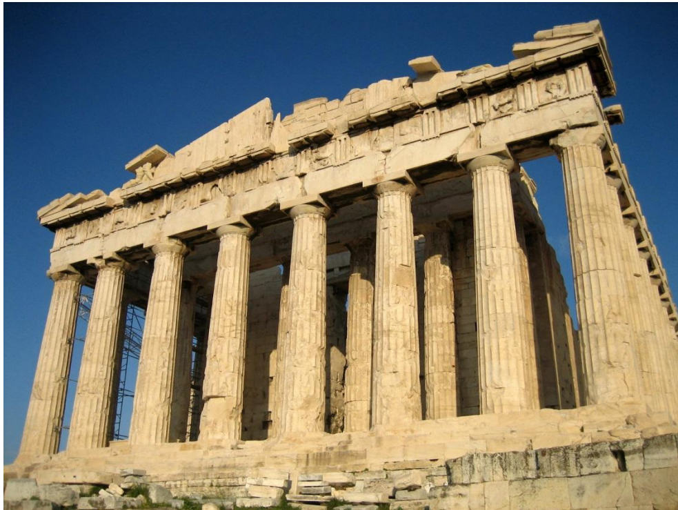
Figura 17 - Parthenon, Grécia - exemplo de sistema viga-pilar construído no século V a.C. Créditos: Wikipédia/Creative Commons
