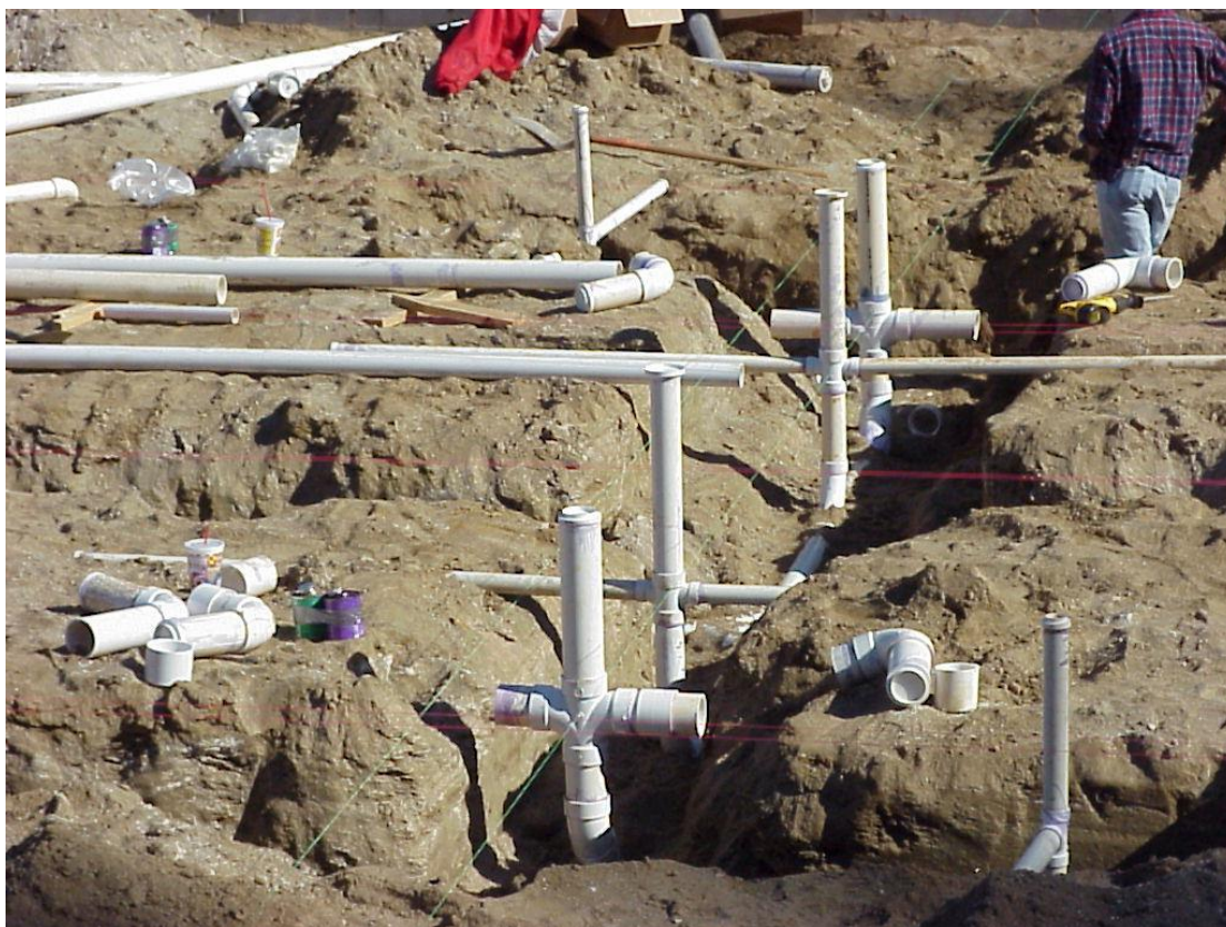
Figura 47 - Execução dos sistemas prediais de esgoto antes da execução da estrutura do Sistema Plataforma
