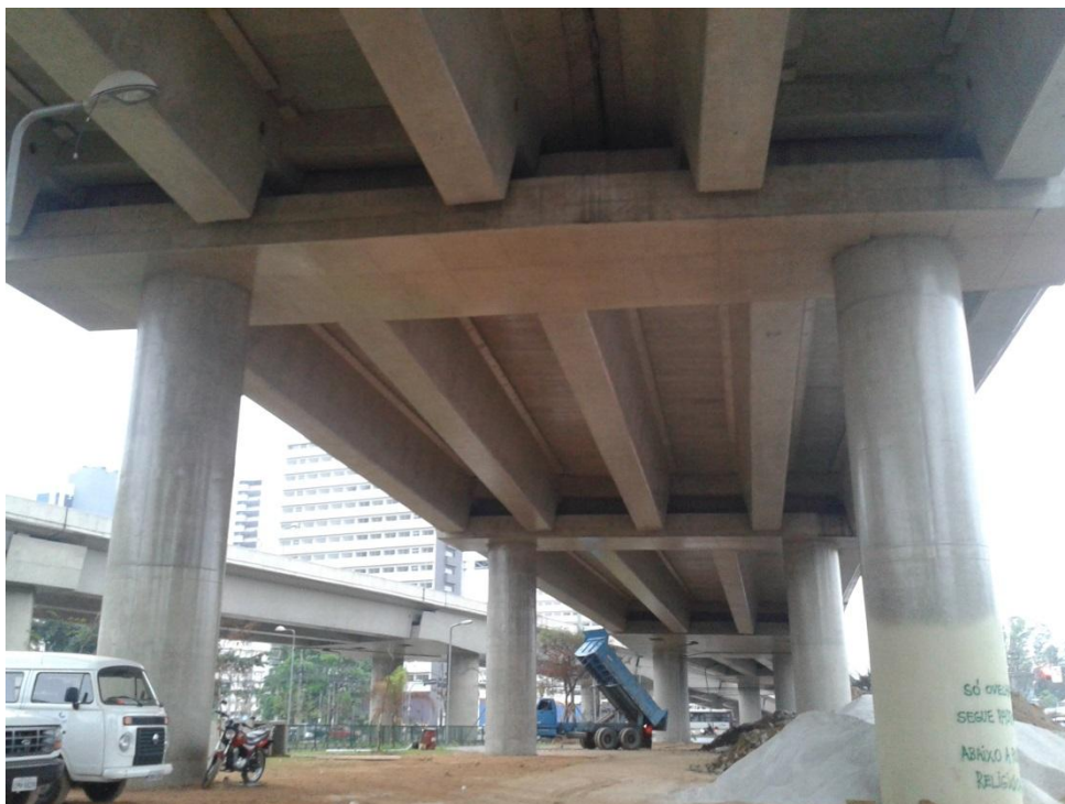
Figura 18 - Viaduto José Bonifácio Coutinho Nogueira, São Paulo, SP – Exemplo de sistema viga-pilar em concreto armado e protendido Créditos: Lucas Marchesi (2013)
