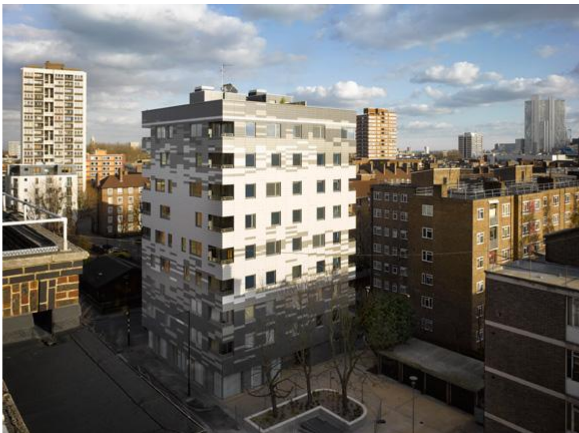
Figura 11 - Edifício residencial com painéis estruturais em CLT, Inglaterra, 2009
