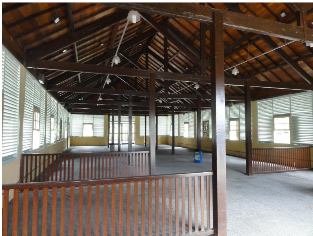
Figura 19 - Antigo Mercado da Vila de Paranapiacaba, Santo André, SP – Exemplo de sistema viga-pilar em madeira, construído em 1899
