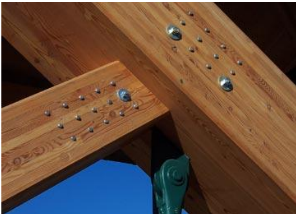
Figura 28 - Ligação com pregos e barras roscadas.
