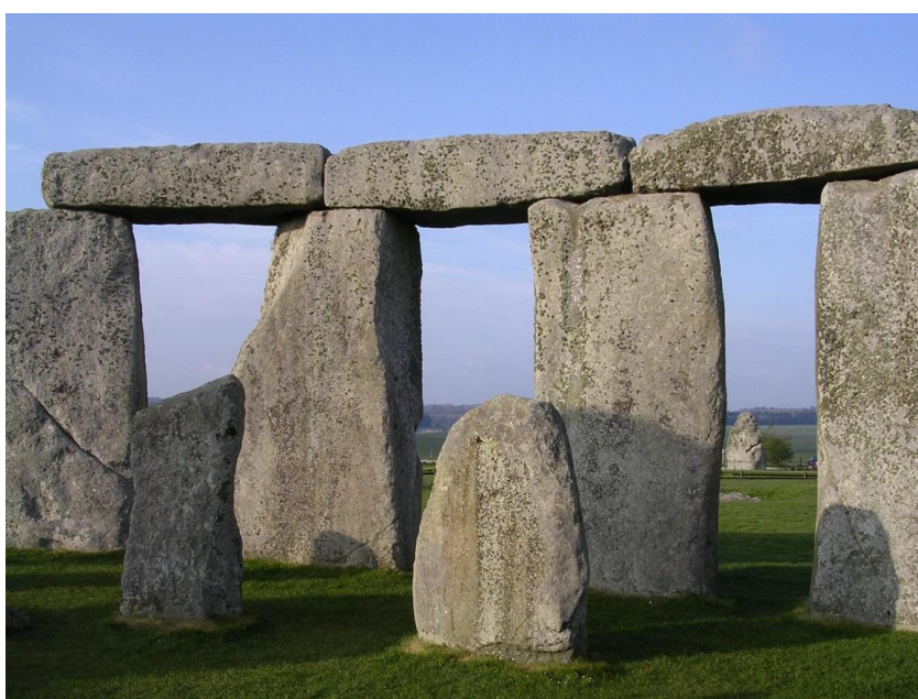
Figura 16 - Stonehenge, Inglaterra - Exemplo de sistema viga-pilar construído em torno do ano 3000 a.C
