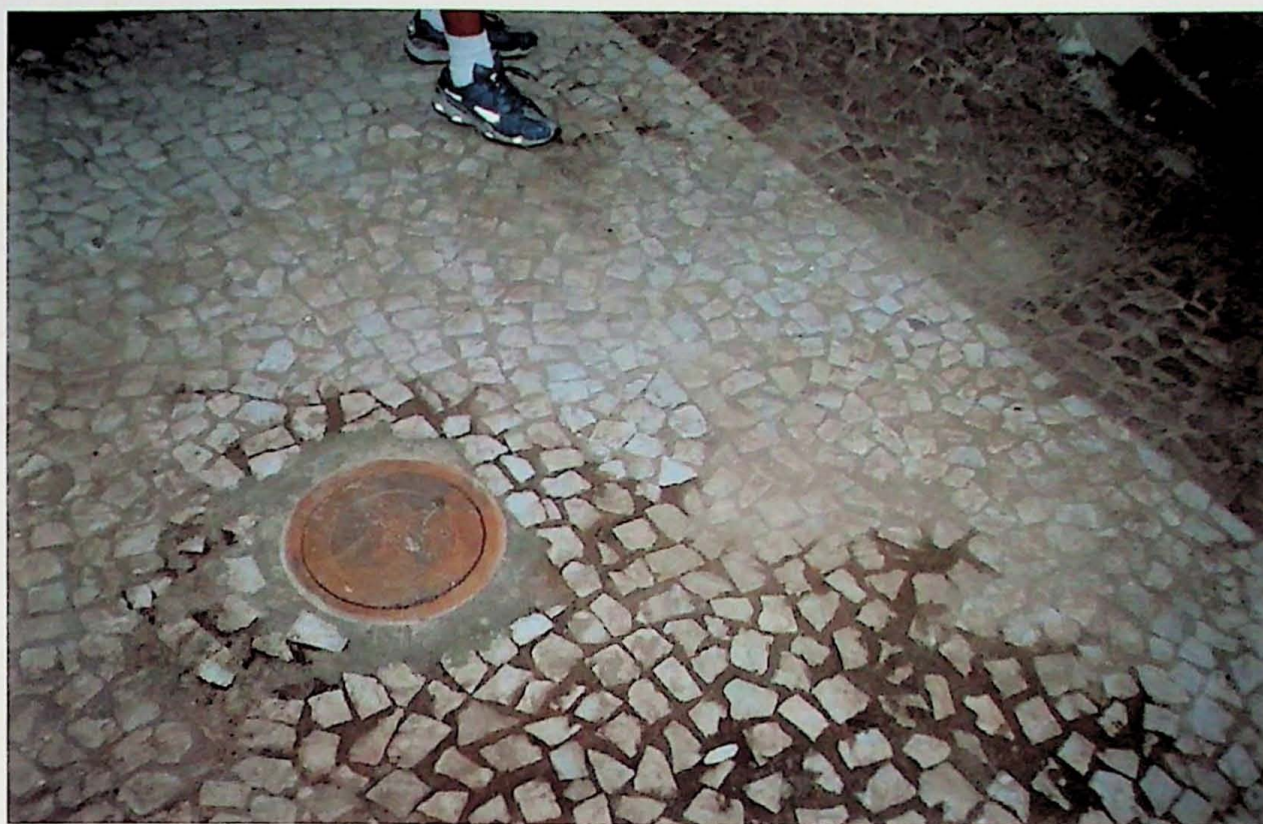
Foto 8.6.2: Poço de extração finalizado.
