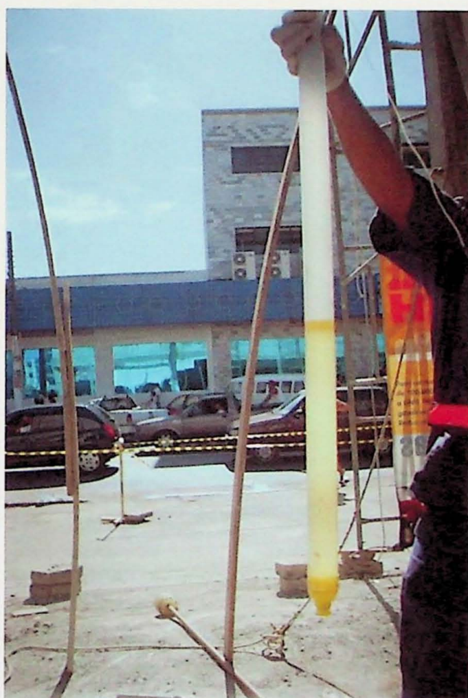
Foto 8.7.1: Espessura de fase livre no PME-02 no mês de instalação do sistema.
