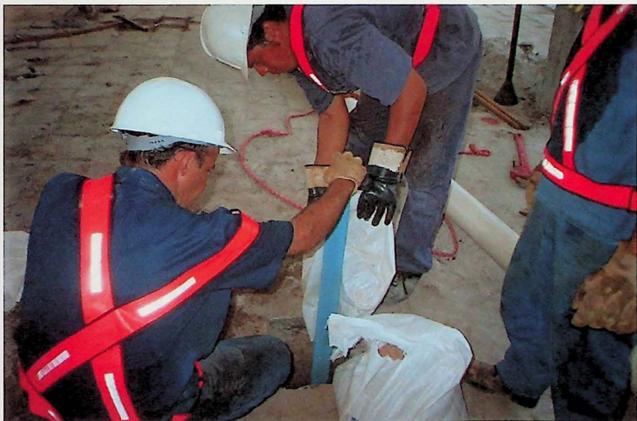
Foto 8.6.1: Construção de um poço de extração.
