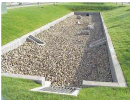
Figura 22 - Filtro de areia de superfície. Fonte: Portland, 2000.
