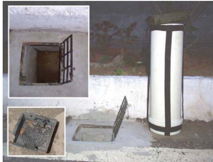
Figura 10 - Amostrador Simples, com detalhe para a vista superior do local onde fica instalado o amostrador (sarjeta) e para a grade retentora de sólidos grosseiros. Fonte: UFRN (s/d).
