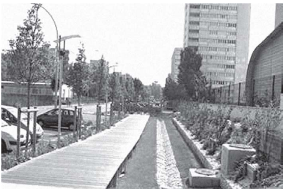
Figura 15 - Exemplo de trincheira de infiltração combinada com vala de retenção, em Seine-Saint-Denis, França. Fonte: Prosab, 2005.
