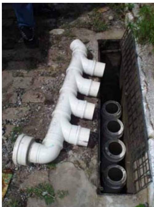
Figura 11 - Amostrador composto a ser instalado na sarjeta. Fonte: Adaptado de UFRN (s/d).
