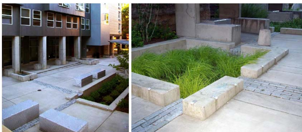
Figura 75 - Canterios de biorretenção instalados nos dormitórios da Universidade de Portland. Fonte: Moura, 2014.
