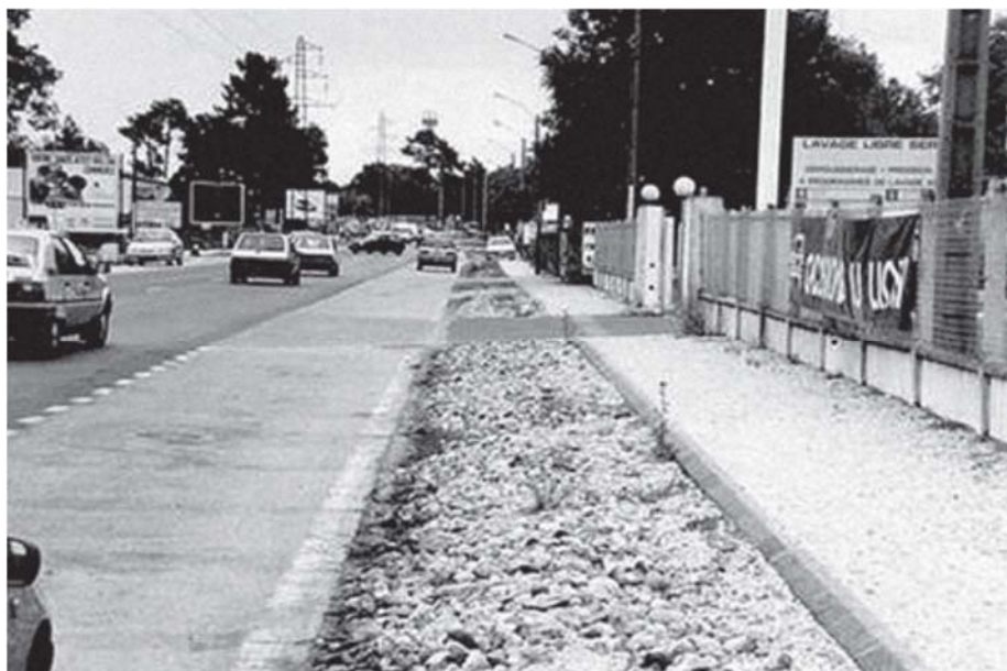
Figura 14 - Exemplo de trincheira de infiltração simples, em Seine-Saint-Denis, França. Fonte: Prosab, 2005.
