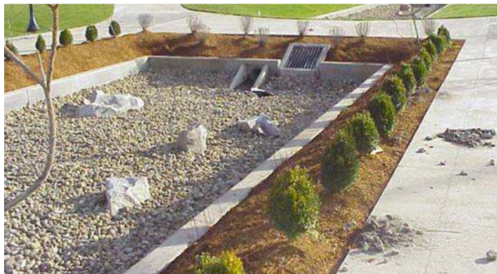
Figura 21 - Filtro de areia de superfície. Fonte: Portland, 2000.
