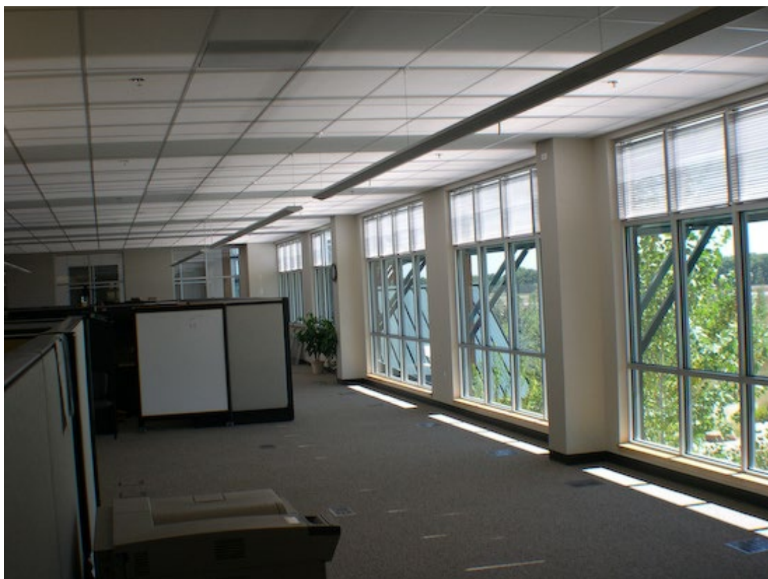
Figura 16 - Exemplo de aplicação do sistema LightLouver, no Xilinx Development Center Longmont, Colorado. Disponível em https://bit.ly/30XLZQT . Acesso em: 10/05/2022
