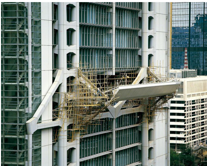
Figura 10 - Vista do elemento externo de reflexão durante a construção (ADEY, 2020)
