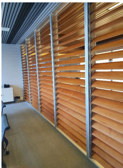
Figura 18 - Exemplo de aplicação de um brise horizontal como divisória interna. Foto da autora
