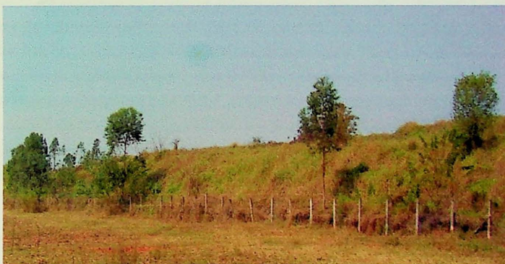
Fotografia 01 – Vista do talude do aterro na porção norte.
