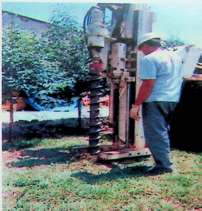
Fotografia 3: Sondagem a trado mecânico para instalação do PM-01.
