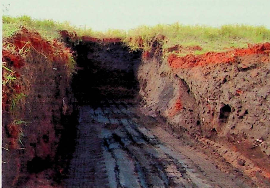
Fotografia 05: Trincheira 1 realizada no aterro, entre o PM-1 e o PM-4.
