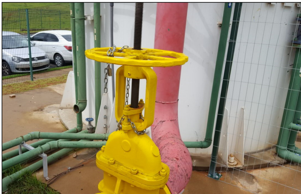
Figura 37 - Bloqueio do registro principal de água do reservatório
