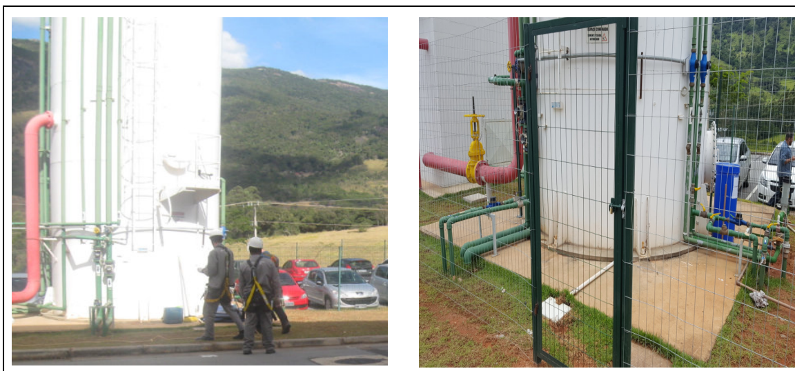
Figura 41 – Fechamento da área de acesso ao reservatório tipo torre vertical
