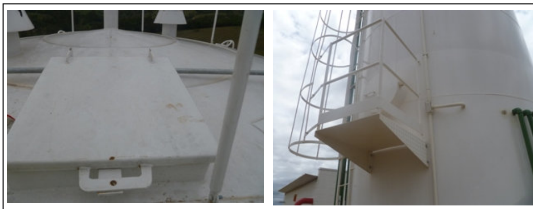
Figura 21 – Acesso superior e plataforma de descanso
