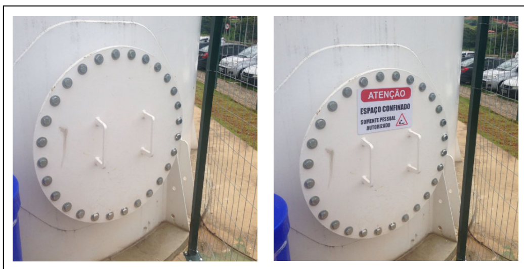
Figura 40 - Sinalização de boca de entrada tanque de reuso de água
