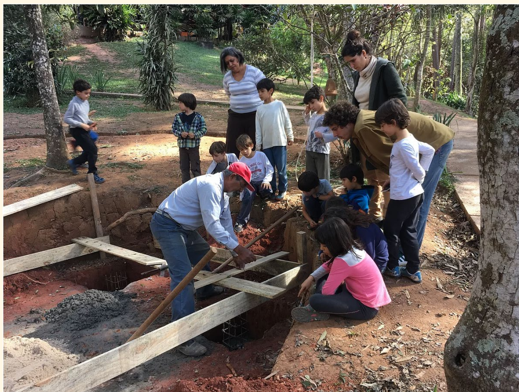
Fundação da construção. Fonte: Site da Escola Ágora.
