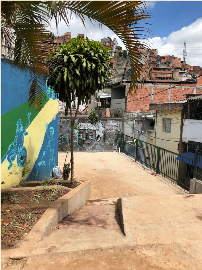
Praça com as obras de infraestrutura finalizadas. Foto: Acervo CoCriança.
