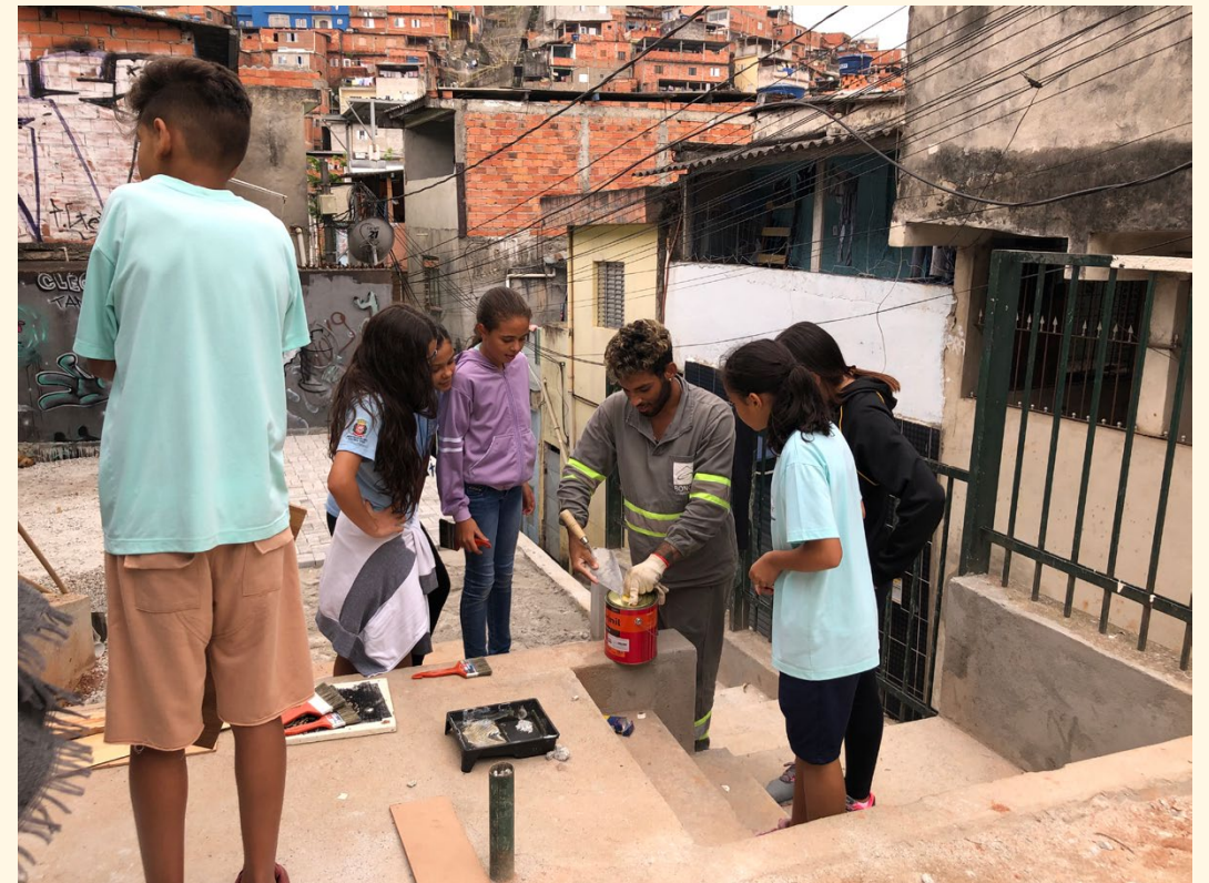
Oficina de construção na praça, enquanto aconteciam as obras infraestruturais com mão de obra especializada. Foto: Acervo pessoal da autora.
