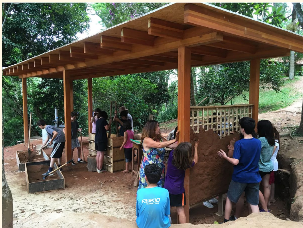
Construção coletiva da parede de pau a pique, e, mais ao fundo, de bancada de taipa de pilão. Fonte: Site da Escola Ágora.
