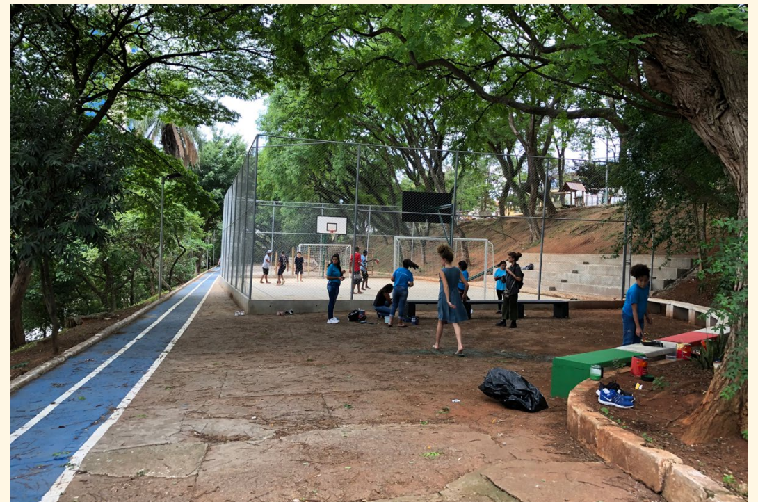
Praça do Samba durante e após as obras de infraestrutura. Fotos: Acervo CoCriança.
