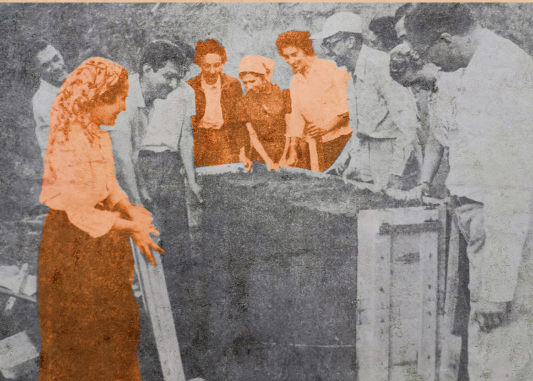
Figura 52- Alunos durante a compactação de terra para construção dos blocos. Centro Interamericano de Vivienda y Planeamiento (CINVA). Bogotá, 1961.
