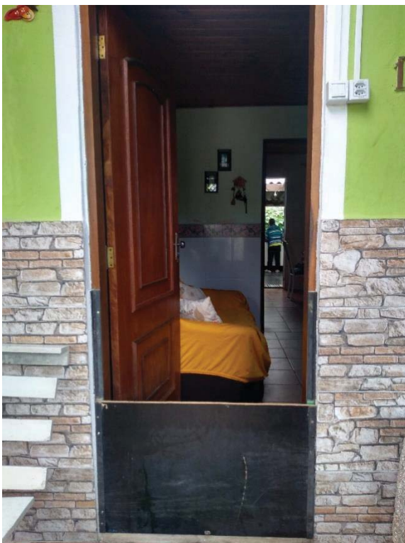
Figura 18 - Comporta de 60cm instalada na entrada da residência de Dona Efigênia (fonte: Mayara Bispo, 2022)
