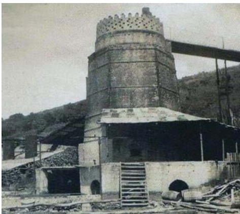
Figura 2 - Forno de alvenaria em primeiro plano existente no local antes da chegada dos Beneduce. Ao fundo, os fornos metálicos: acervo pessoal família Beneduce. (fonte: livro Cajamar - Cidade de Lutas e Conquistas)
