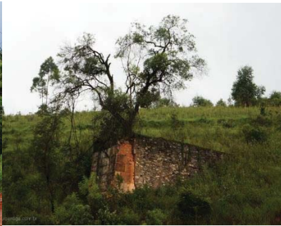
Figura 10 - Resquícios da antiga ponte que sustentava os trilhos em direção à vila Bocaina em situação degradante, com vegetação nos interstícios da estrutura (fonte: Douglas Nascimento, 2013)
