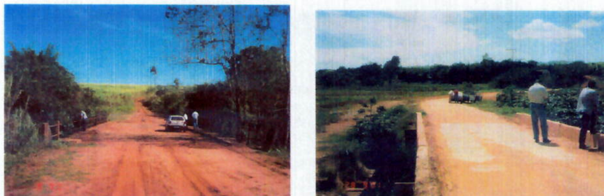
Figura 3.3 – Pontes e estradas rurais.
