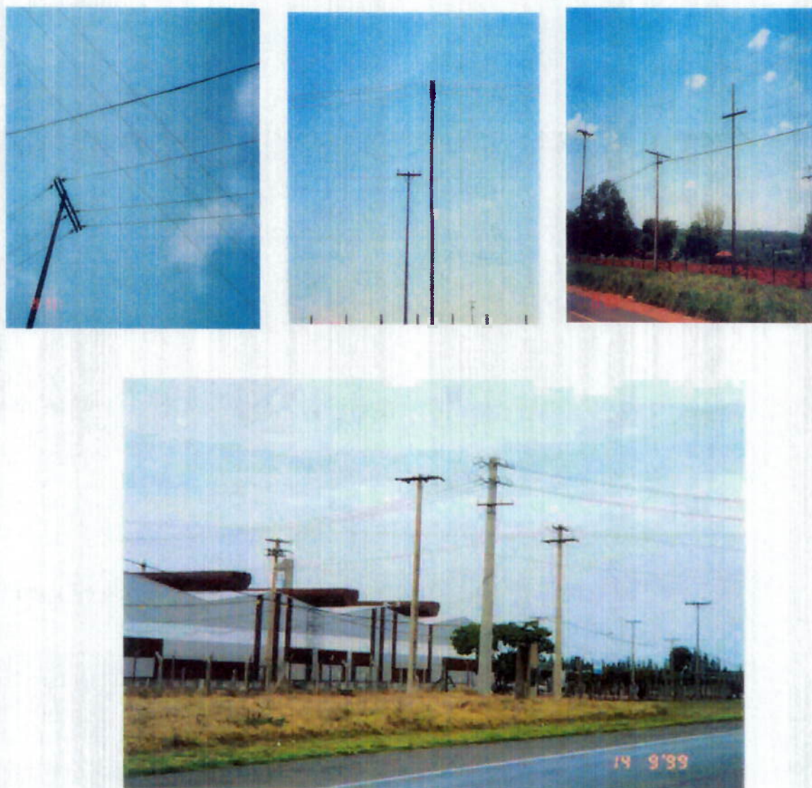
Figura 3.11 – Cruzamentos de redes de distribuição
