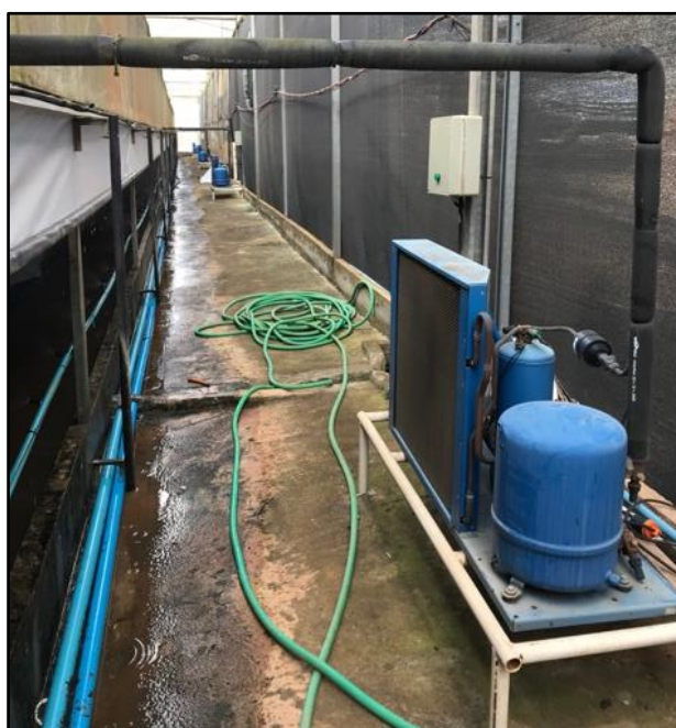
Figura 18. Compressores da câmara fria
