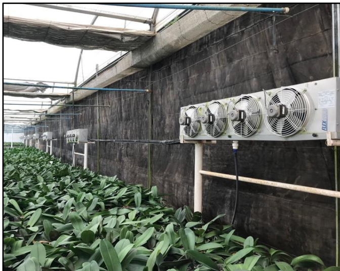
Figura 19. Ventiladores da câmara fria
