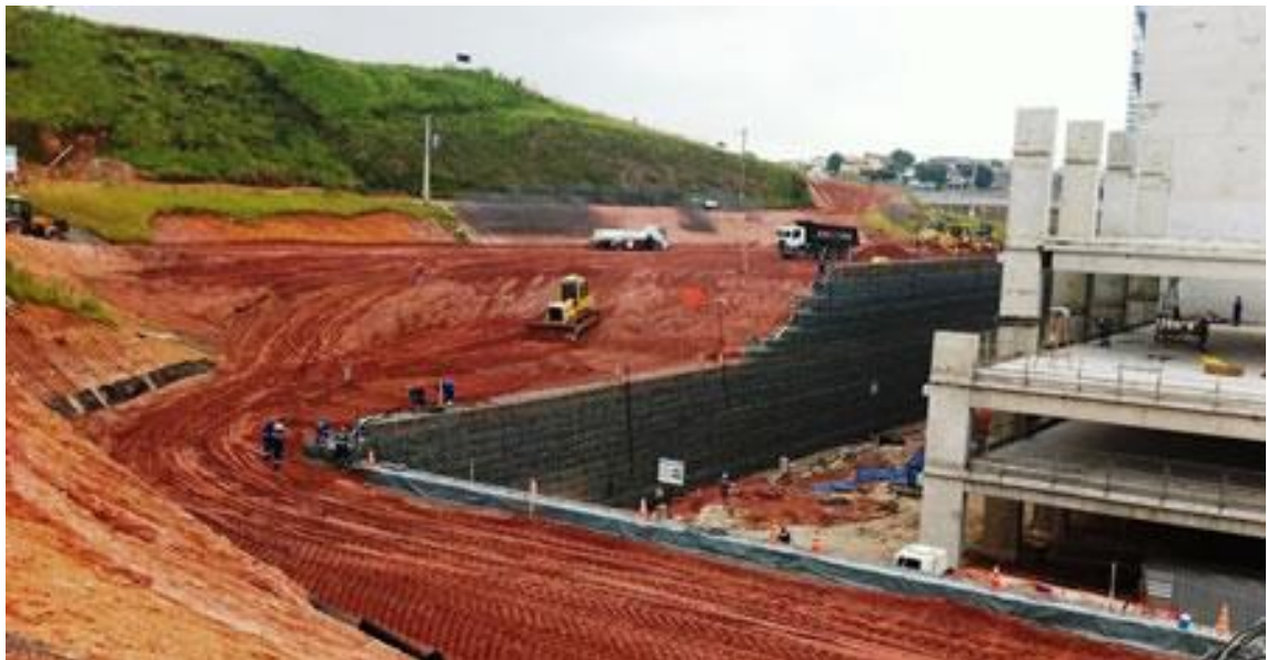
Figura 12: Construção do muro de contenção da arena Corinthians com solo exposto. Fonte: Santos, P. J. dos, et al.
