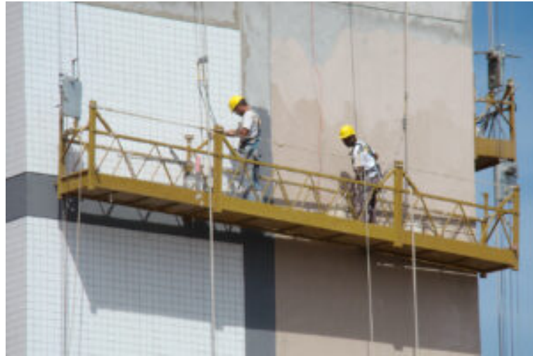
Figura 2 – Andaime (balancim elétrico)
