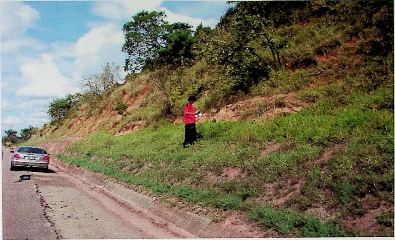
Foto 17-02 Vista geral, afloramento de arenito.
