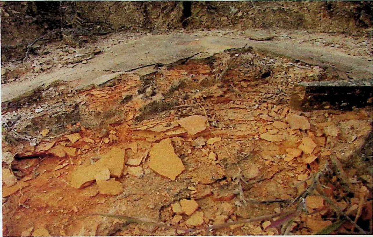
Foto 26-01 Siltito argiloso laminado, muito alterado.
