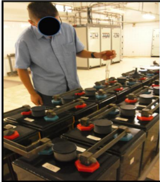
Figura 44 – Operador executando manutenção nos bancos de baterias estação B Fonte: Arquivo pessoal (2012)
