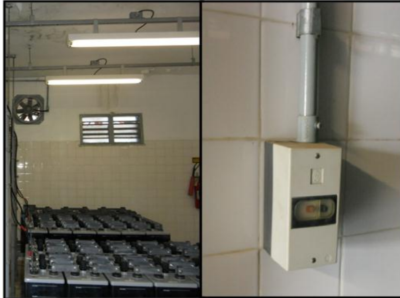
Figura 51– Detalhe iluminação e interruptor da sala de baterias estação B Fonte: Arquivo pessoal (2012)
