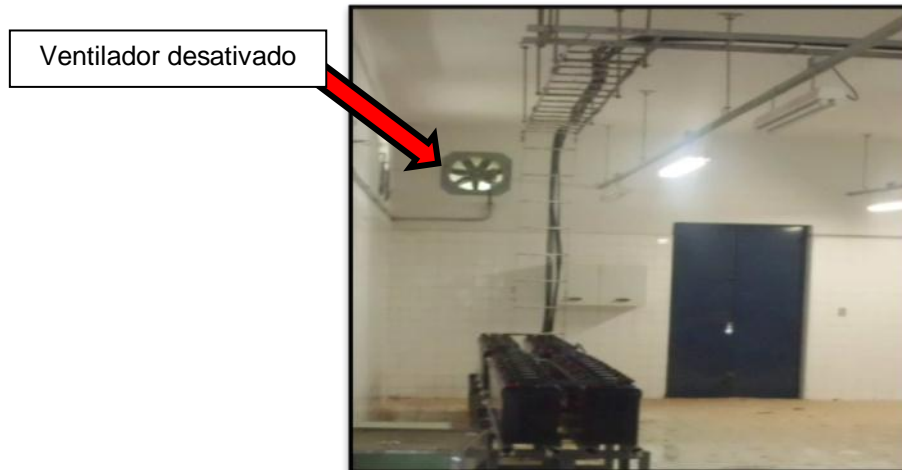
Figura 34 – Ventilação sala de baterias estação B Fonte: Arquivo pessoal(2012)
