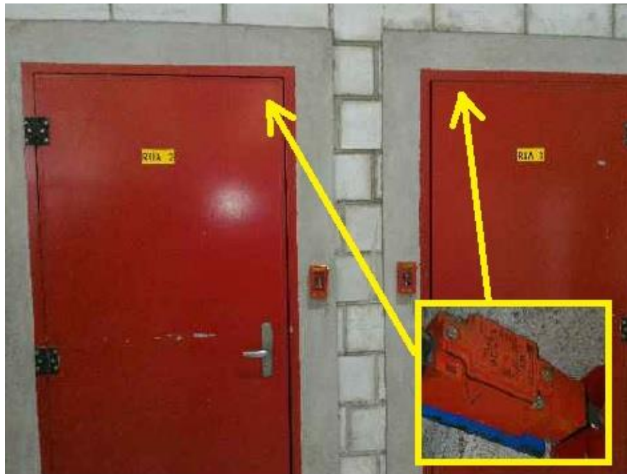
Figura 21 – Portas de emergência e detalhe do sensor antigo
