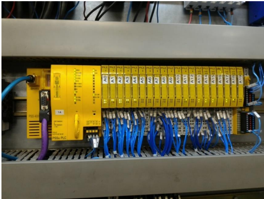
Figura 44 – CLP de segurança principal / semelhante aos CLPs localizados
