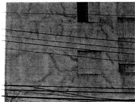
Figura 1.9- Fissuração do revestimento.
