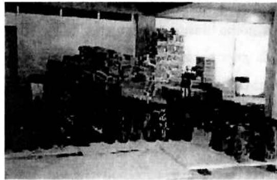
Figuras 1.3 e 1.4 – Areia dosada e embalada em obra, pronta para ser transportada para o pavimento de produção da argamassa.
