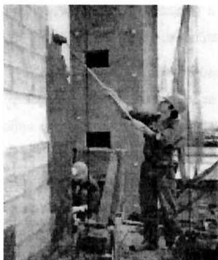
Figura 3.14 - Execução do chapisco rolado.
