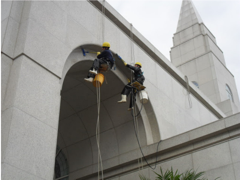
Figura 7 - Pintura e Limpeza de fachada
