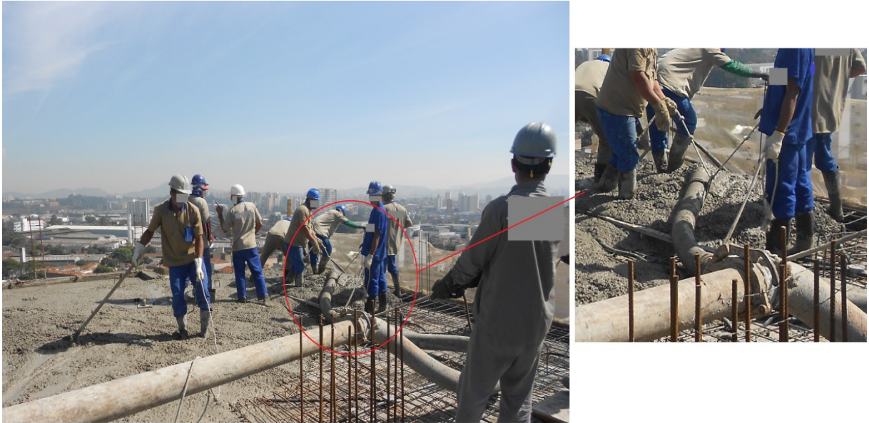
Figura 32 - Concretagem de Estrutura
