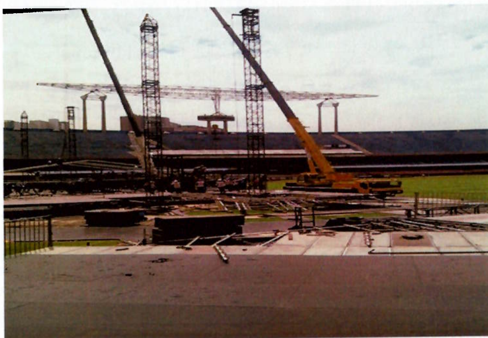
Figura 11 - Posicionamento de guindastes para içamento de estruturas de palco – - Show ACDC – Morumbi – Nov/2009 –
