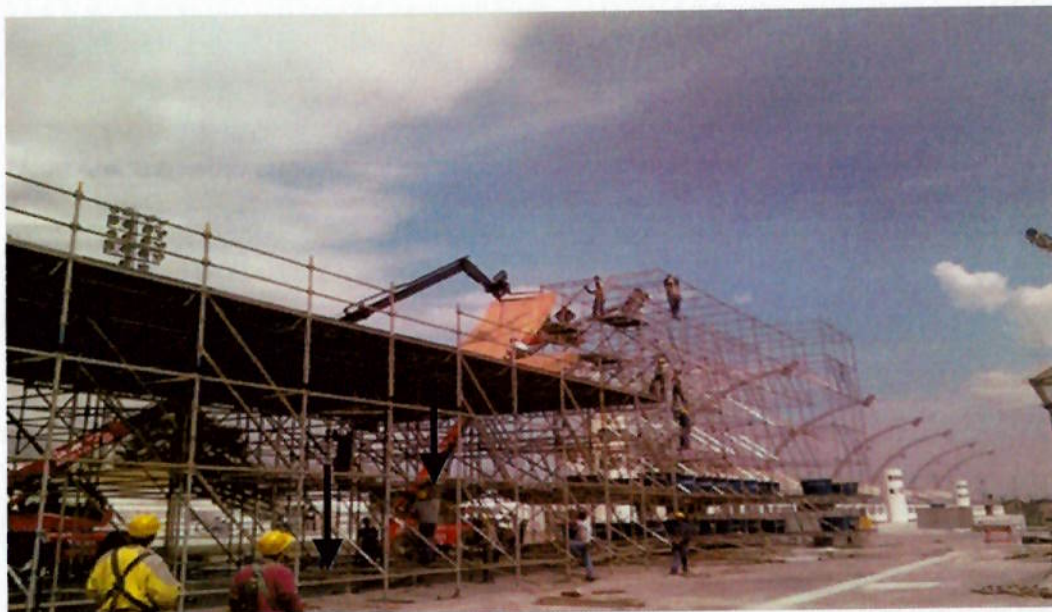
Figura 10 - Detalhes : Travessas horizontais superiores e inferiores – - Montagem de Estrutura para pista de Skate – Anhembi – Out/2009 –
