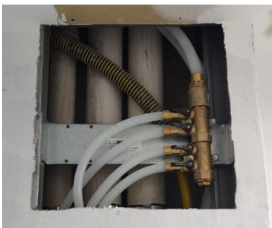
Figura 8 - Kit manifold (módulo distribuidor) para sistema PEX
