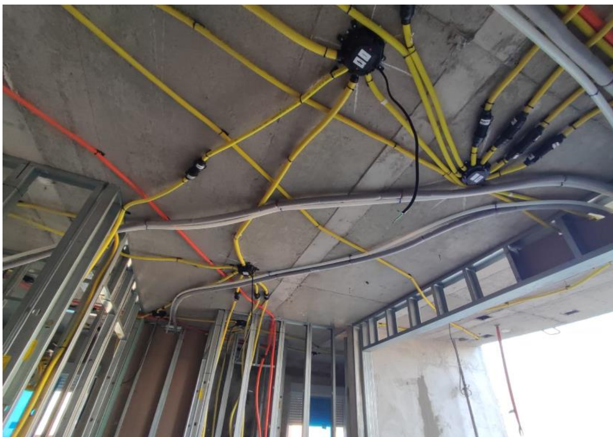
Figura 10 - Chicote elétrico pré-montado instalado e testado
