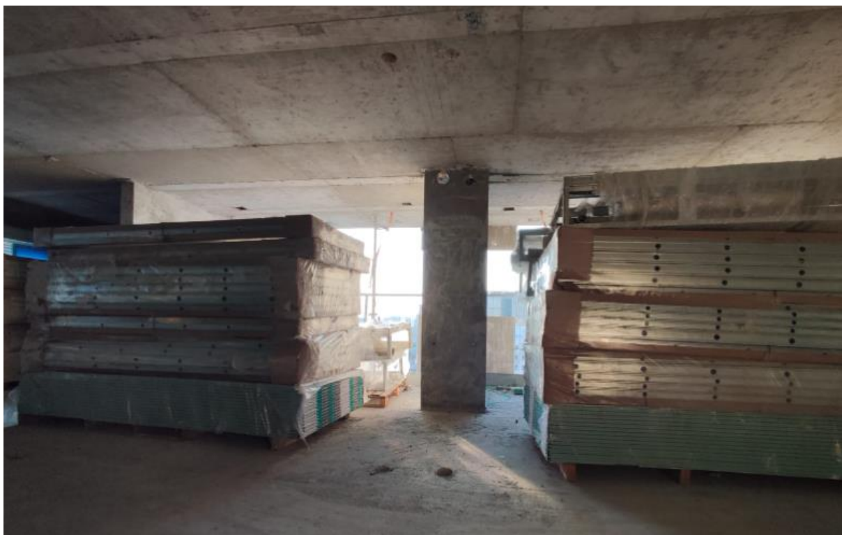
Figura 21 - Armazenamento de módulos Smart Wall sobre placas de gesso acartonado no pavimento destino
