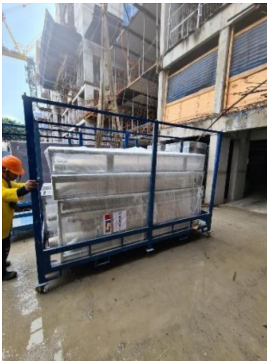
Figura 16 - Preparação e movimentação dos módulos de shafts hidráulicos com carrinhos
