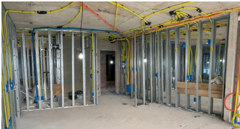
Figura 13 - "SMART WALL" - Integração industrializada de instalações elétricas e hidráulicas em paredes modulares de drywall
