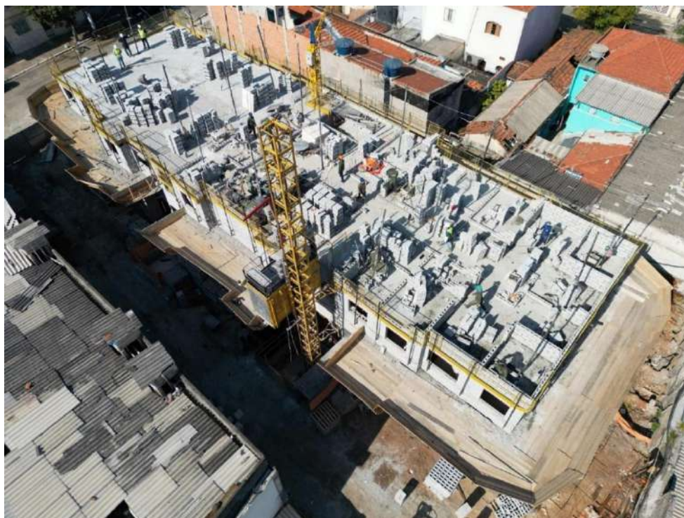
Figura 14 - Vista aérea dos fundos do Caso A
