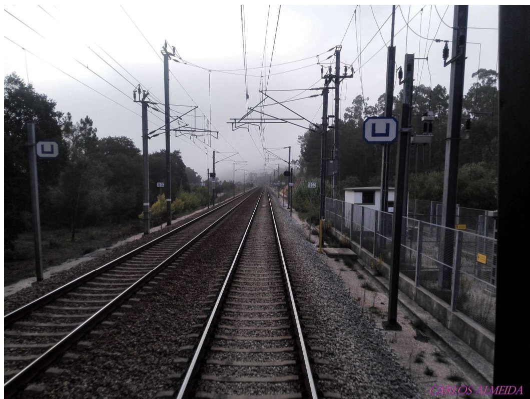
Figura 36 - Zona Neutra de Caxarias. Linha do Norte, Portugal.
