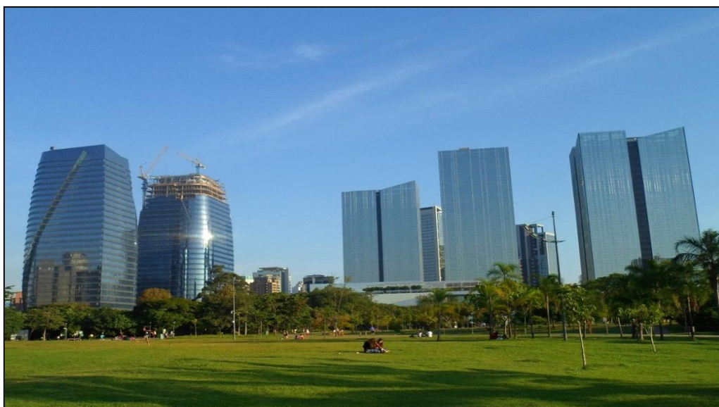
Figura 9 – Prédios espelhados da Vila Olímpia, localizados na Avenida Juscelino Kubitschek e Avenida Olimpíadas, respectivamente. Foto: Bueno Netto
