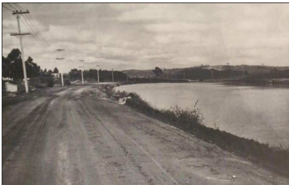
Figura 4 – Novo canal do Rio Pinheiros, recém construído, década de 1930. Ao fundo, a região do Morumbi. Fonte: Fundação Patrimônio Histórico da Energia do Estado de São Paulo.
