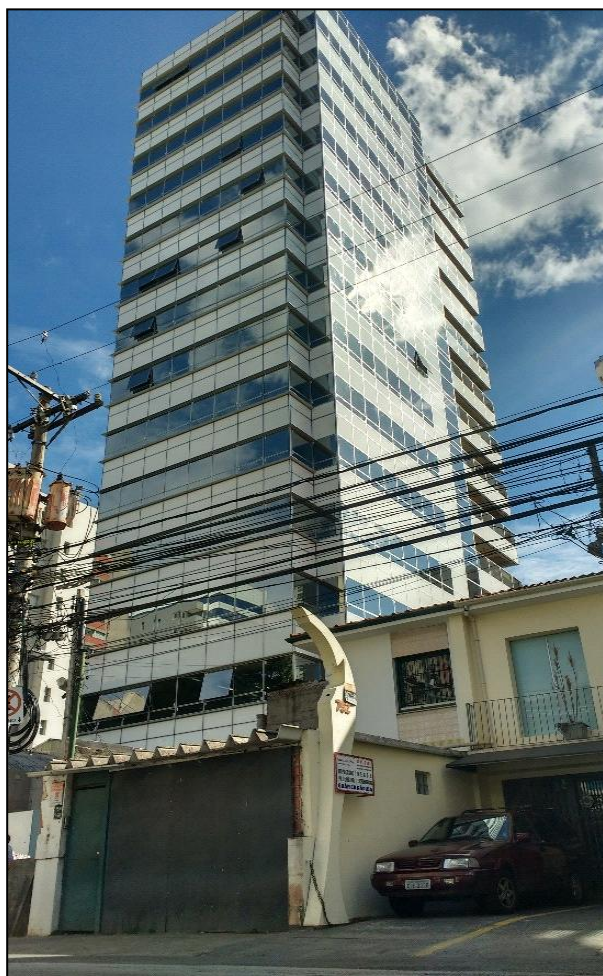
Figura 8 – Foto de prédio comercial na Vila Olímpia. Foto: Fernando Farina.
